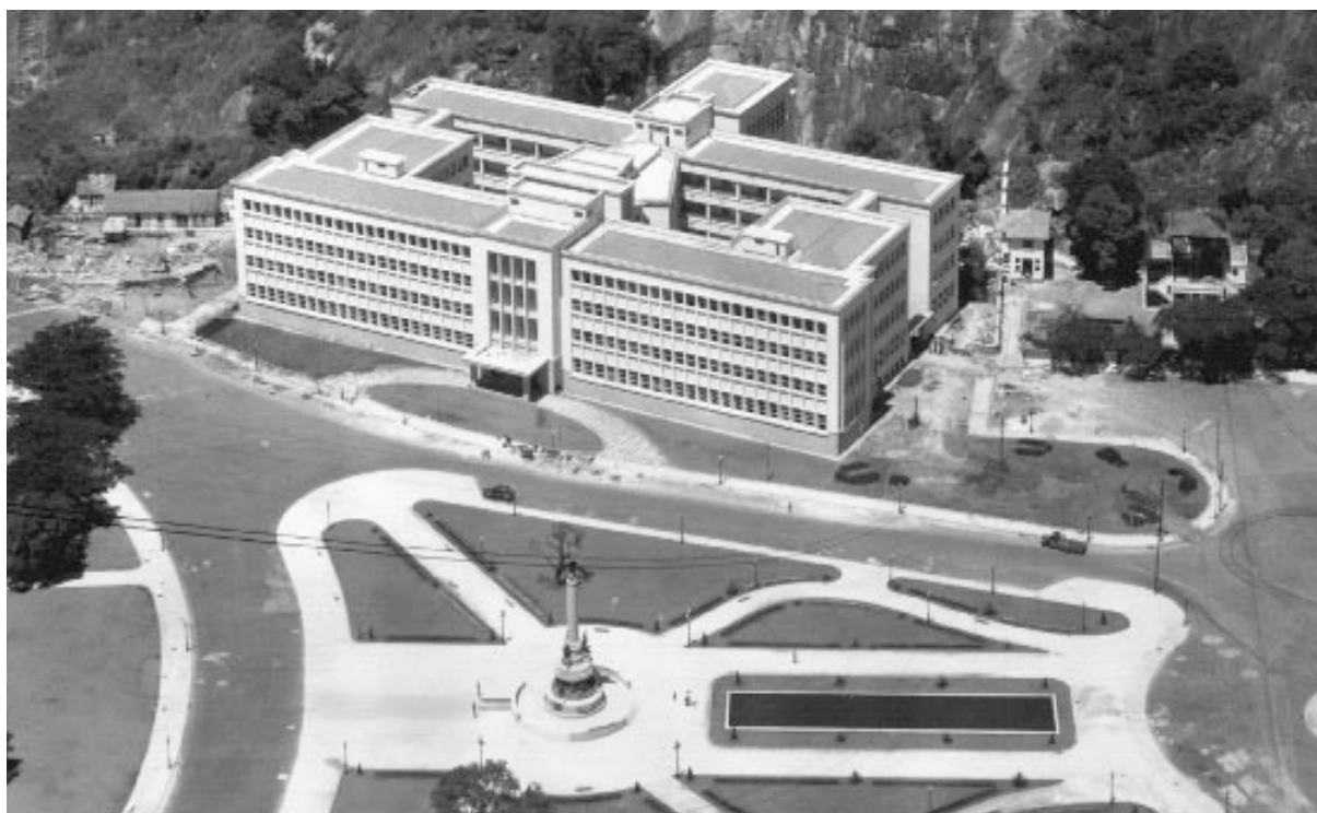
Fotografia 21 Vista aérea do edifício
