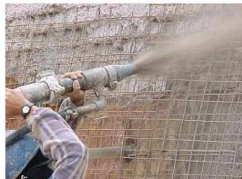
Figura 2 - Etapas construtivas de muros de solo grampeado (adaptado de Clouterre, 1991)
