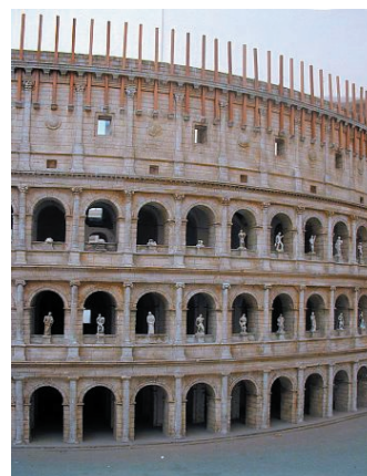
Reconstrução do Coliseu, Roma, 70-80 d.C., combinação das ordens clássicas com muros e aberturas em arco.
