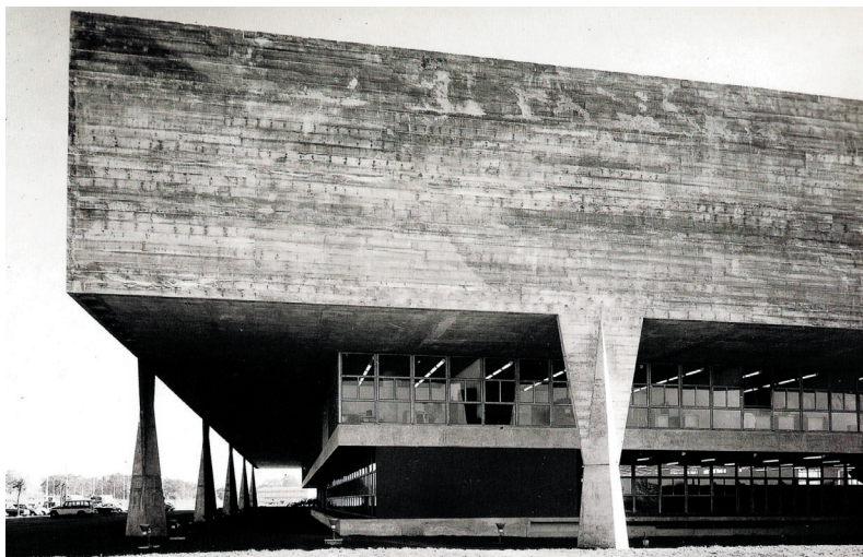
FAU/USP: vista externa.
