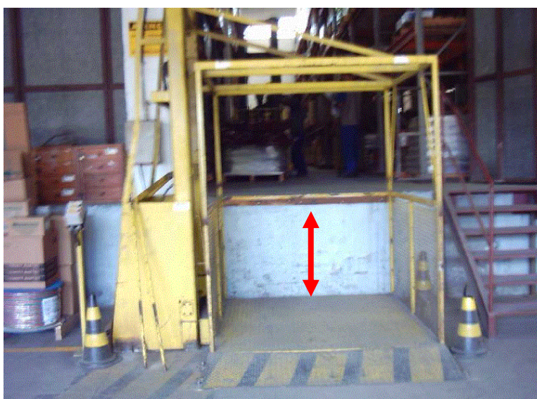
Figura 28 – Elevador de Carga e Desnível entre a área de Picking e a área de Expedição
