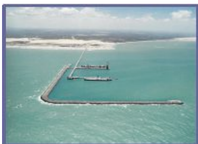
Figura 31 - Terminal Portuário de Pecém
