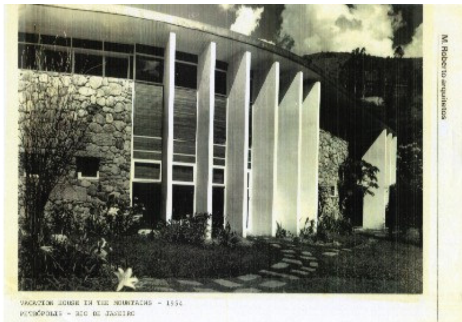
Figura 94 – Residência Tácito Prado
