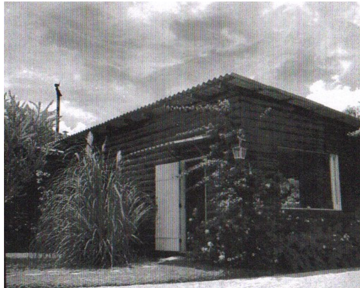
Figura 30 – Residência João Carlos Vital
