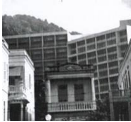
Figura 55 – Edifício Júlio Barreto
