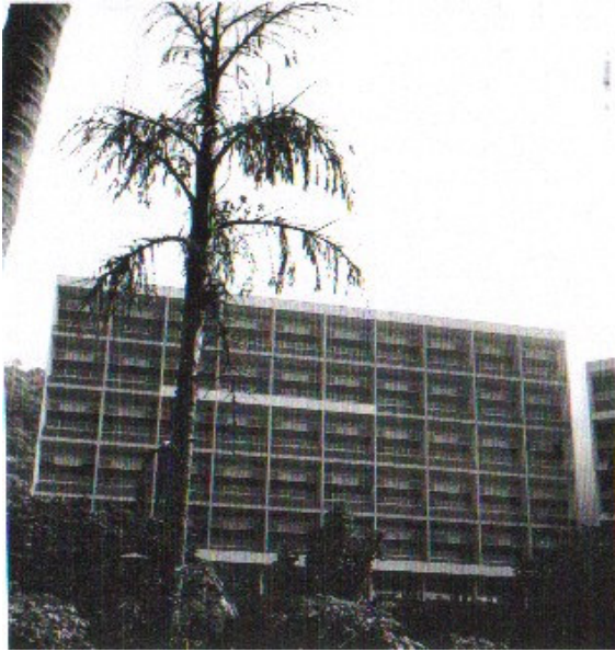
Figura 54 – Edifício Júlio Barreto
