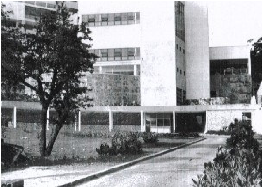
Figura 57 – Edifício Júlio Barreto
