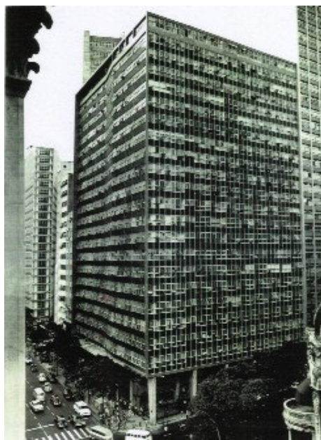
Figura 73 – Edifício Marquês do Herval
