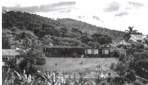
Figura 31 – Residência João Carlos Vital
