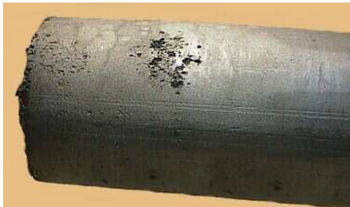
Figura 1.2: Duto com corrosão[9]
