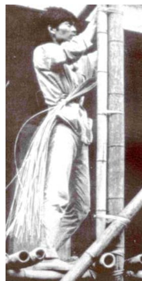
Figura 13 – Fitas de bambu são utilizadas nas amarrações dos andaimes de bambu.
