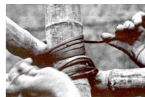
Figura 14 – Fitas de bambu são utilizadas nas amarrações dos andaimes de bambu.
