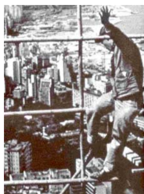
Figura 12 – Andaime de bambu, Hong-Kong: 78º andar.
