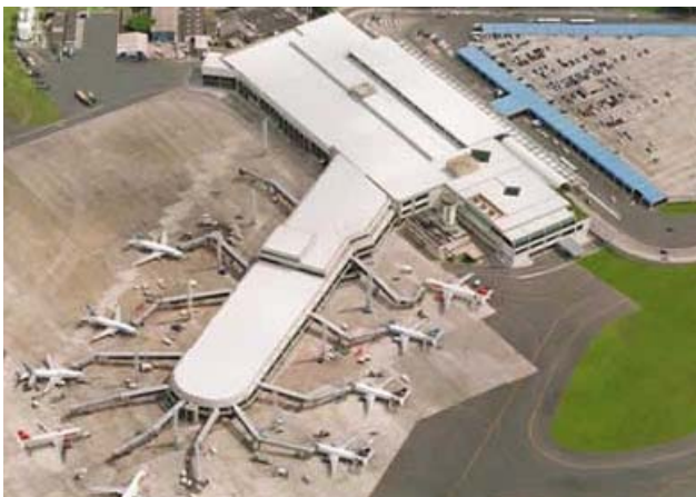
Figura 17: Aeroporto de Salvador – centralizado em vários níveis com píer (Fonte: Aeroportos do Brasil)
