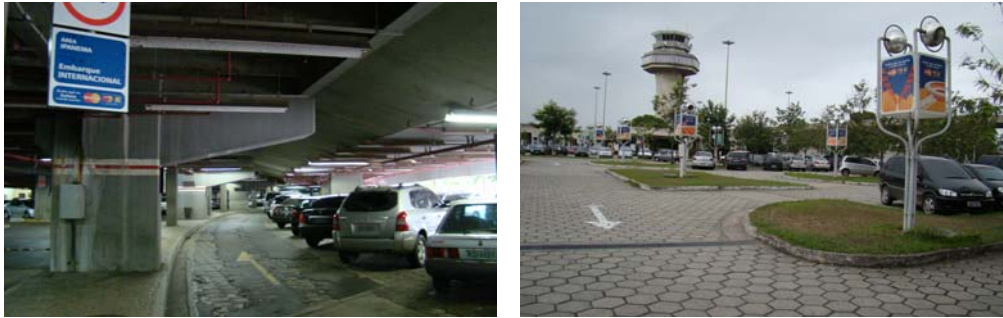
Figura 52: área coberta (esq.) e área descoberta (dir.) do estacionamento – térreo – não possui circulação para pedestres.
