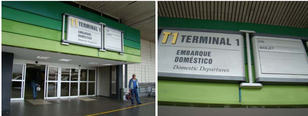
Figura 62: Tamanho da letra da placa de identificação é pequeno.
