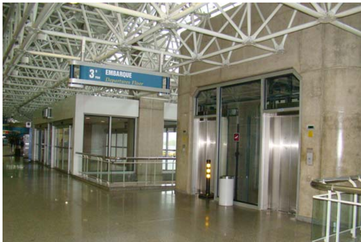
Figura 144: Caixa dos elevadores não se destaca do entorno.
