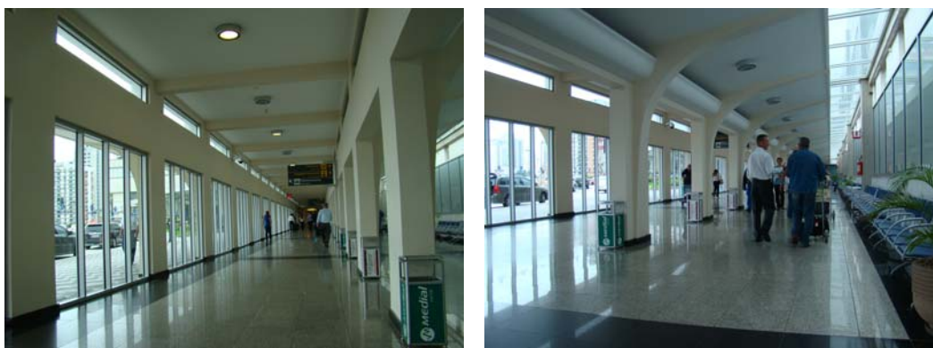
Figura 166: Placa de sinalização do lado esquerdo da circulação fica bloqueada pela marquise no lado direito.
