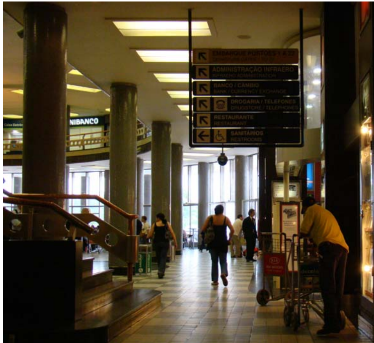
Figura 156: Iluminação inadequada prejudica ver algumas placas de sinalização.
