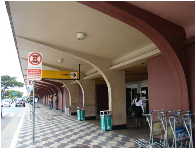
Figura 152: Fachada do terminal destaca a entrada usando cor diferente.
