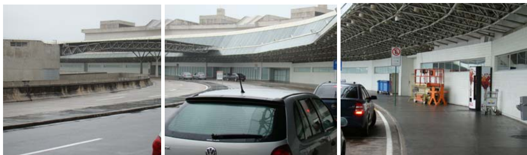
Figura 122: Parte externa do terminal que internamente tem o acesso restrito.
