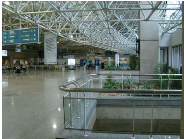
Figura 32: Estrutura metálica e iluminação natural destacam o teto do terminal 2.
