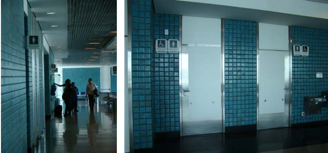
Figura 167: Placa do sanitário para cadeirantes só pode ser vista de frente ao banheiro.
