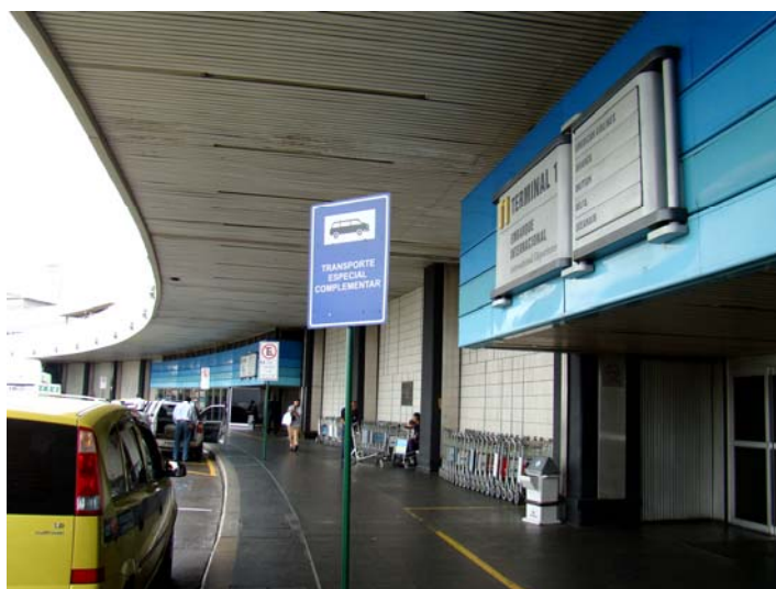
Figura 61: Placa de identificação do setor paralela à circulação.
