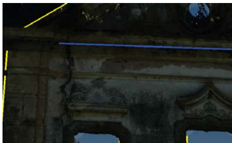
5.6(a): Imagem do Convento de São Boaventura, com transparência de 10%, sobreposta com seu respectivo modelo 3D — ressaltado pelas linhas estruturais em azul e amarelo. Aproximação no detalhe de uma rachadura à esquerda da imagem.
