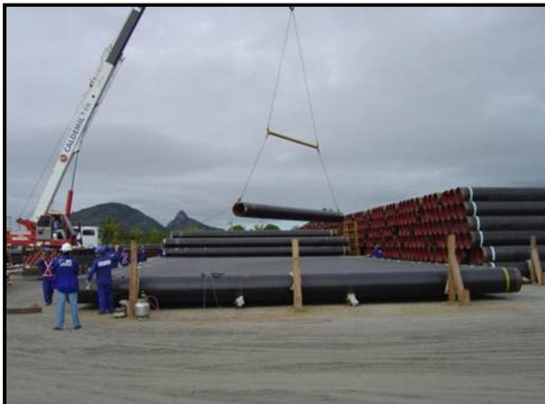
**Ilustração 9 – Utilização de guindastes para elevação da carga**
