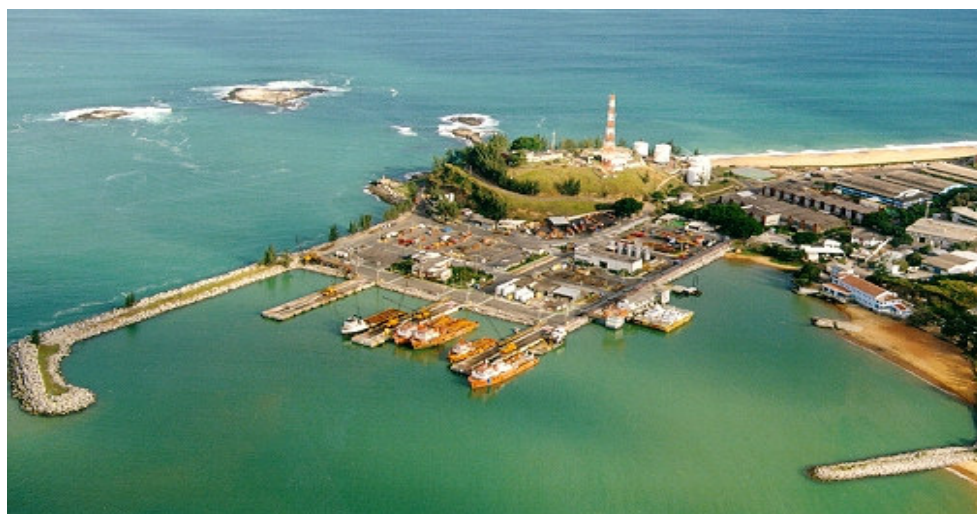
Figura 4 Vista aérea do Terminal Alfandegado de Imbetiba (Fonte: Petrobras)
