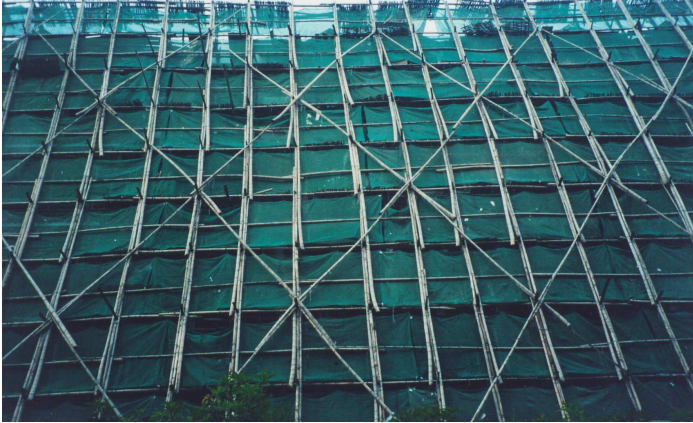
Fig. 17 – malha de bambus nos andaimes chineses.
