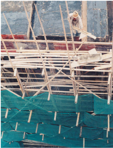
Fig. 16 – operário da construção civil em andaimes na China.
