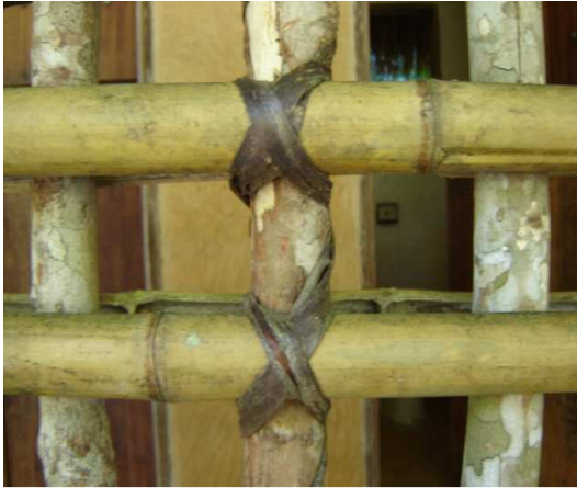
Fig.19 – amarrações com fibras vegetais entre bambus.
