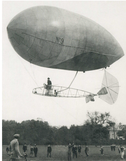
Fig.4 - viga treliçada autotencionada no dirigível nº9.
