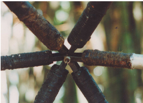
Fig.22 – conexão pontual entre segmentos.
