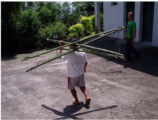
Fig.31 – cruzetas autotencionadas sendo transportadas.
