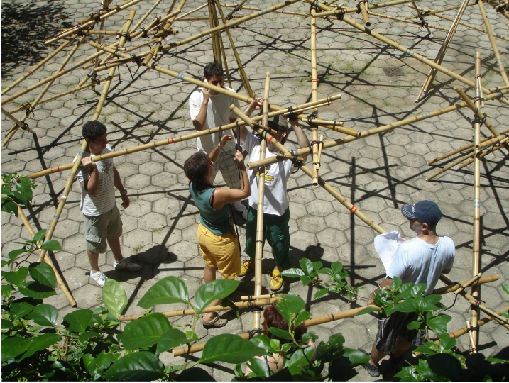
Fig.76 – malha geodésica de bambu atada.
