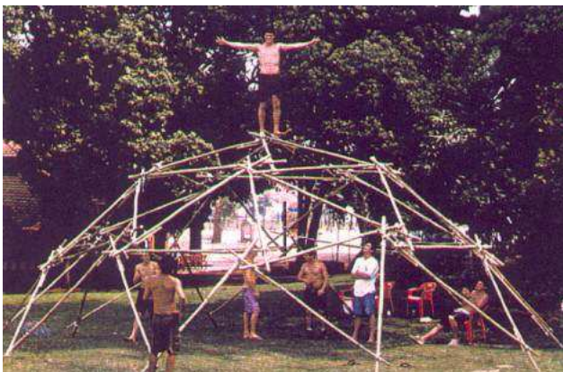
Fig.24 – geodésica de bambu amarrada, Campo Grande, MS.
