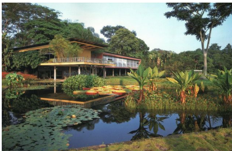
Imagem 84: Residência Olivo Gomes em São José dos Campos
