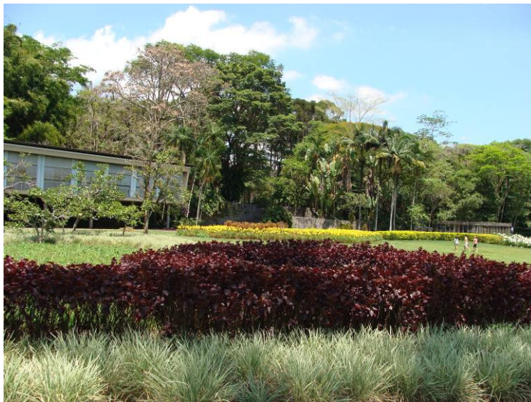
Imagem 86: Residência Olivo Gomes em São José dos Campos
