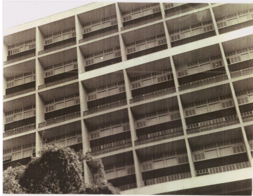
Figura 14C – foto da fachada do bloco B voltada para a Baía de Guanabara
