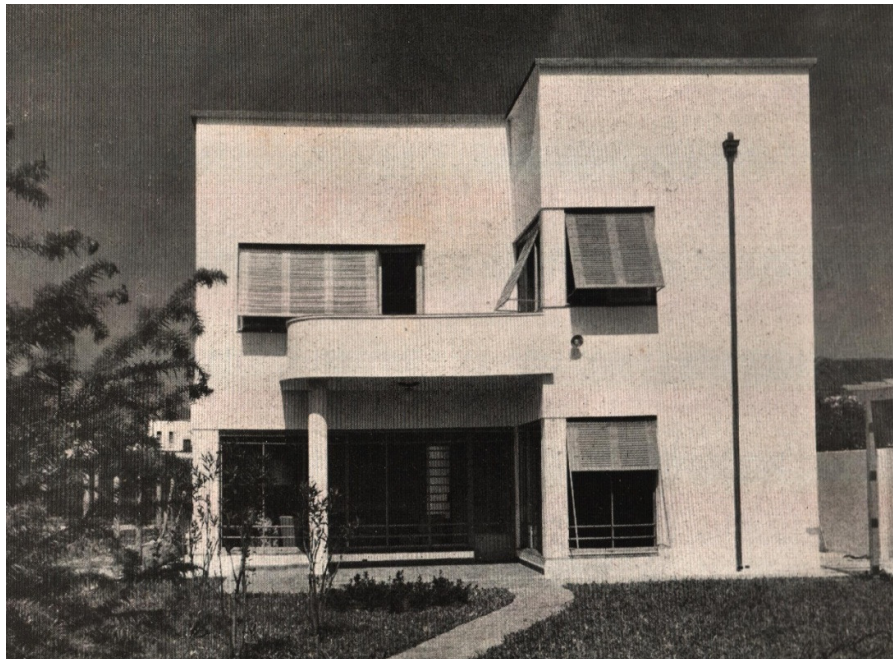
Figura 24B – Foto da fachada posterior
