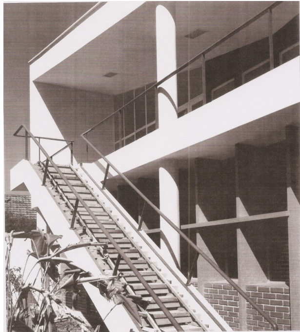
Figura 15B – Foto fachada posterior do edifício da administração
