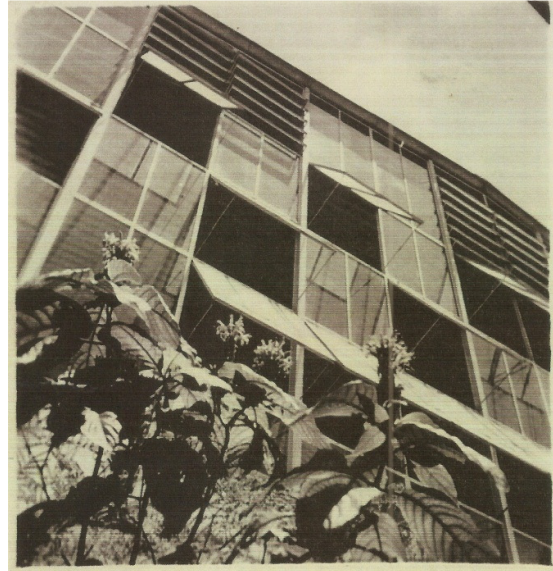
Figura 15C – Foto do fechamento do galpão industrial
