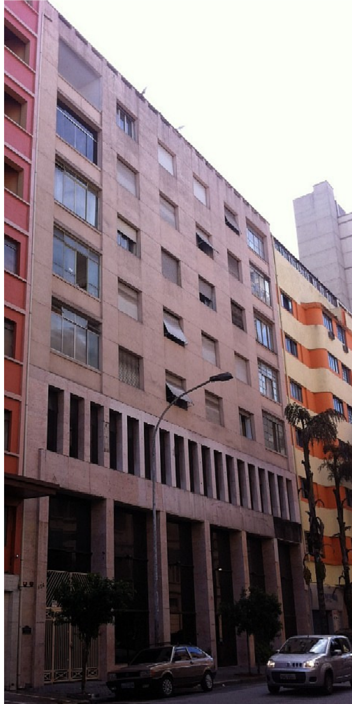
Figura 27A – Foto fachada
