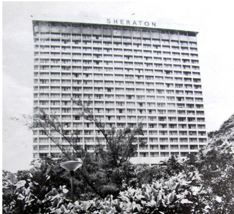
Figura 47A – Foto da fachada voltada para a Praia do Leblon
