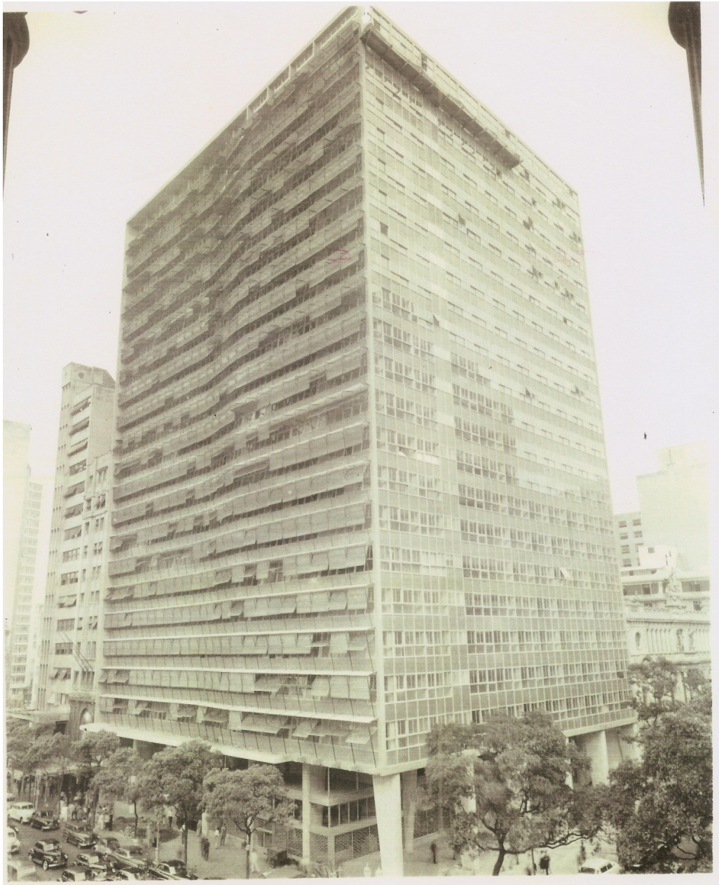
Figura 19A – Foto das fachadas (quando da inauguração)
