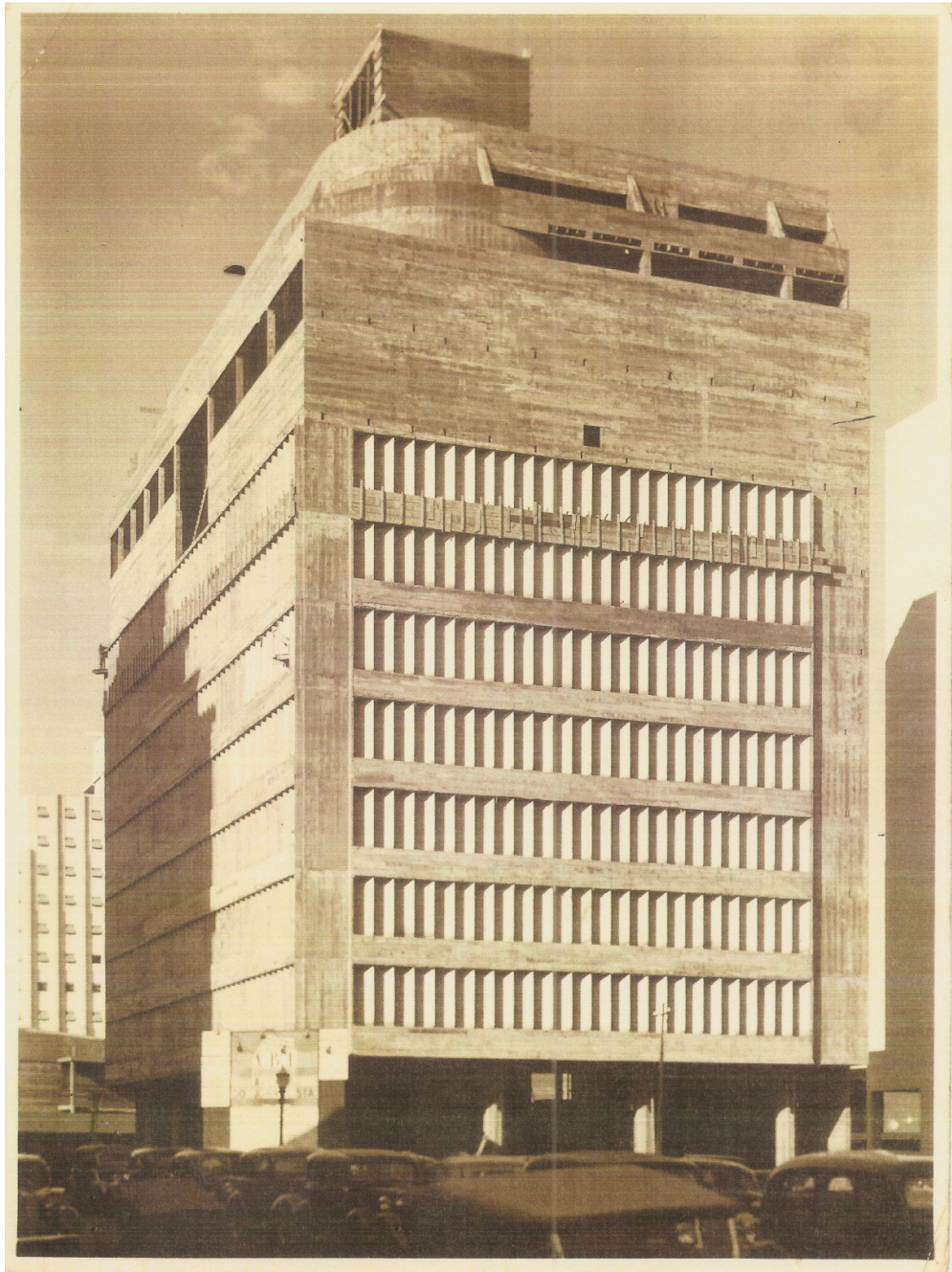
Figura 1K – Foto do edifício em construção, fachada Rua México
