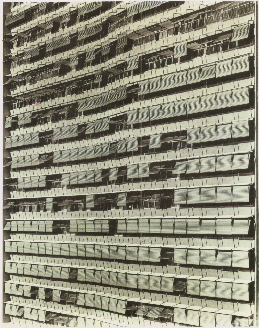
Figura 19B – Foto dos brises-soleils da fachada voltada para Avenida Rio Branco
