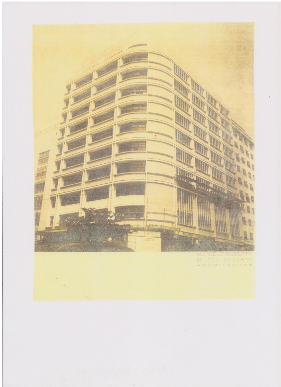
Figura 3A – Foto do Edifício Sede do IAPI em construção
