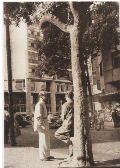
Figura 13G – Foto de Milton e Maurício Roberto em frente ao Edifício Seguradoras
