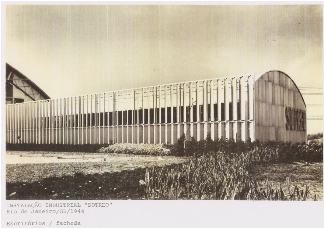
Figura 10E – Foto dos brises-soleils do galpão de escritórios
