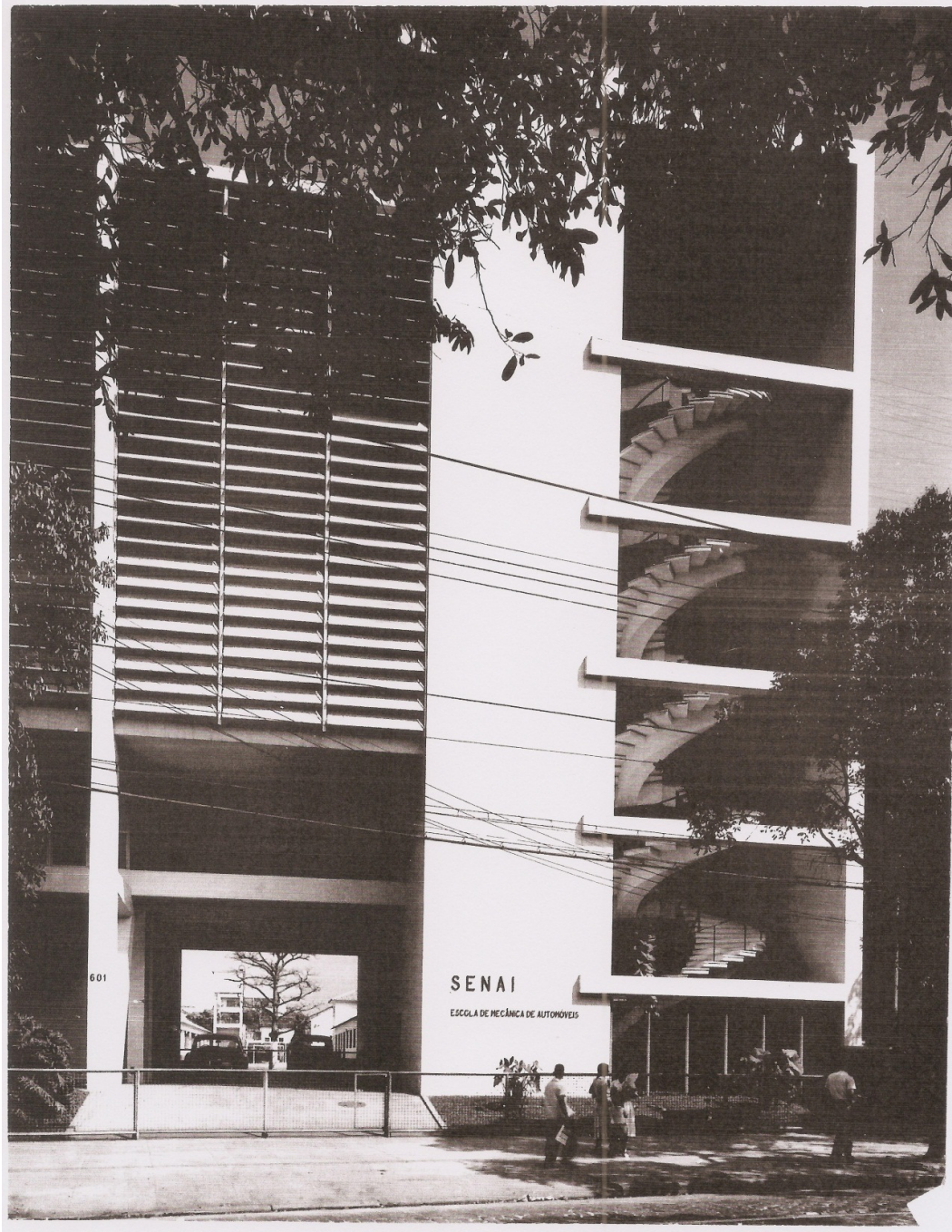
Figura 18B – Foto da fachada principal
