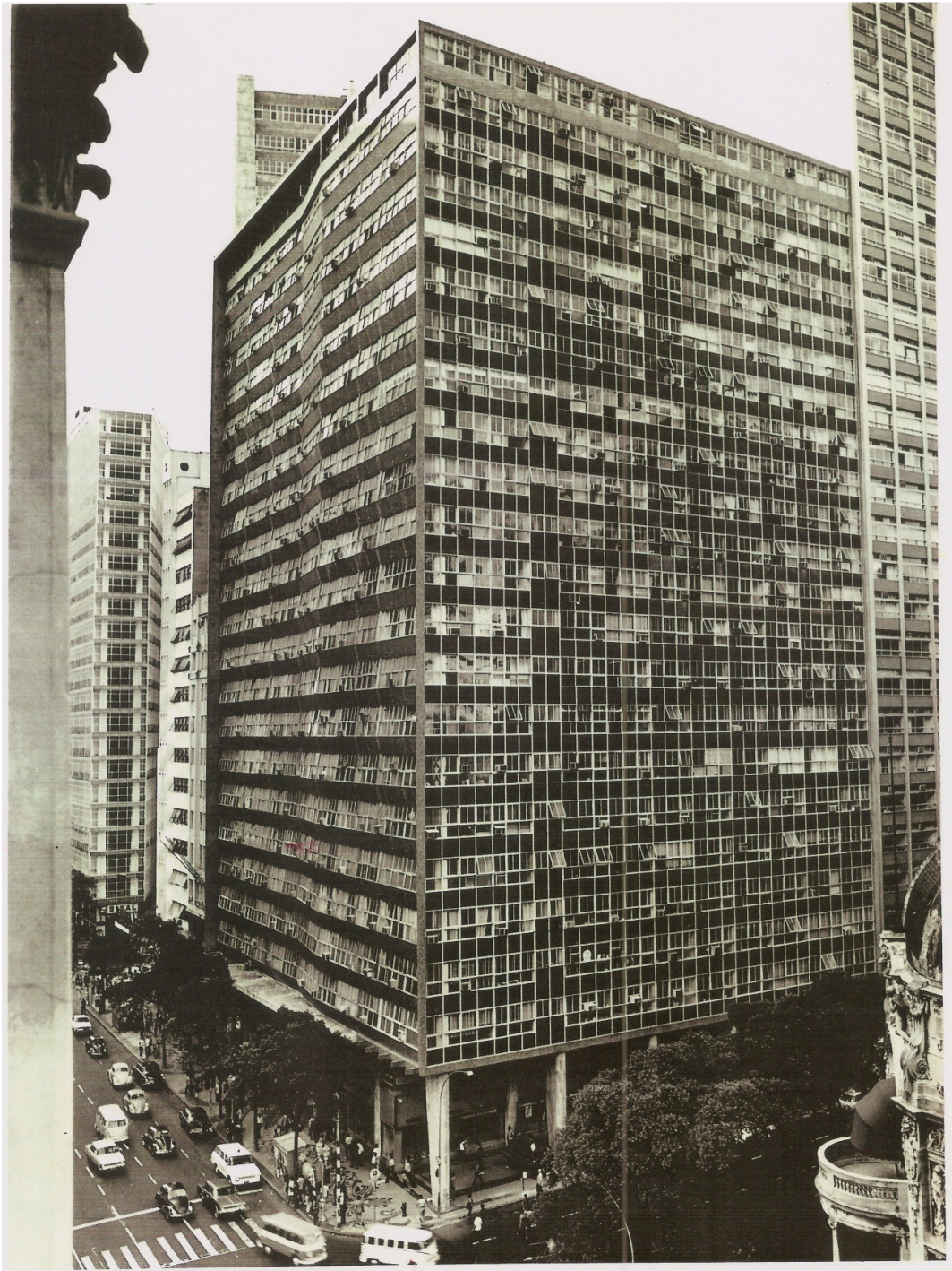
Figura 19H – Foto do edifício após a retirada dos brises-soleils
