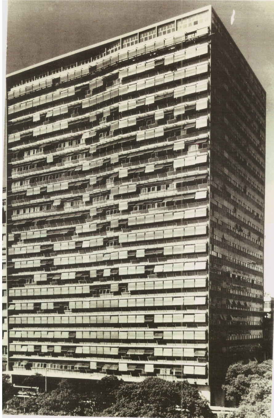
Figura 19C – Foto da fachada
