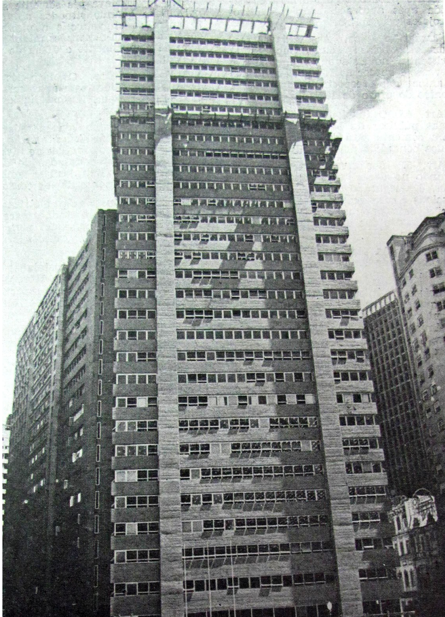
Figura 43A – Foto da fachada principal (edifício ainda em construção)
