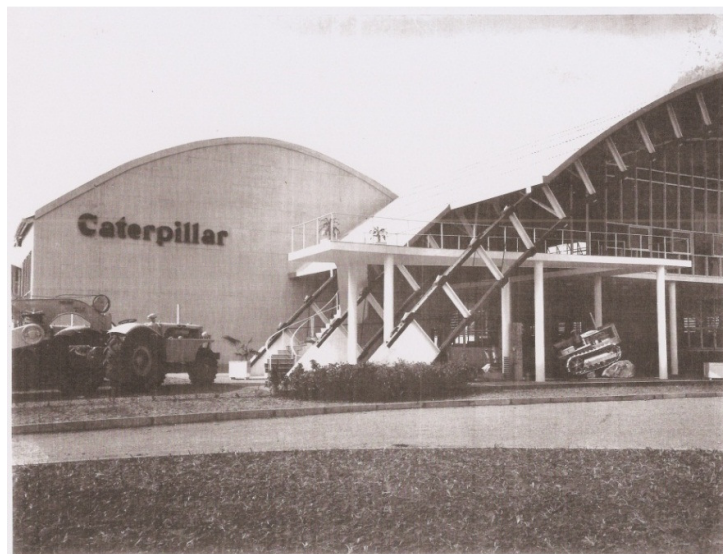
Figura 10C – Foto da fachada
