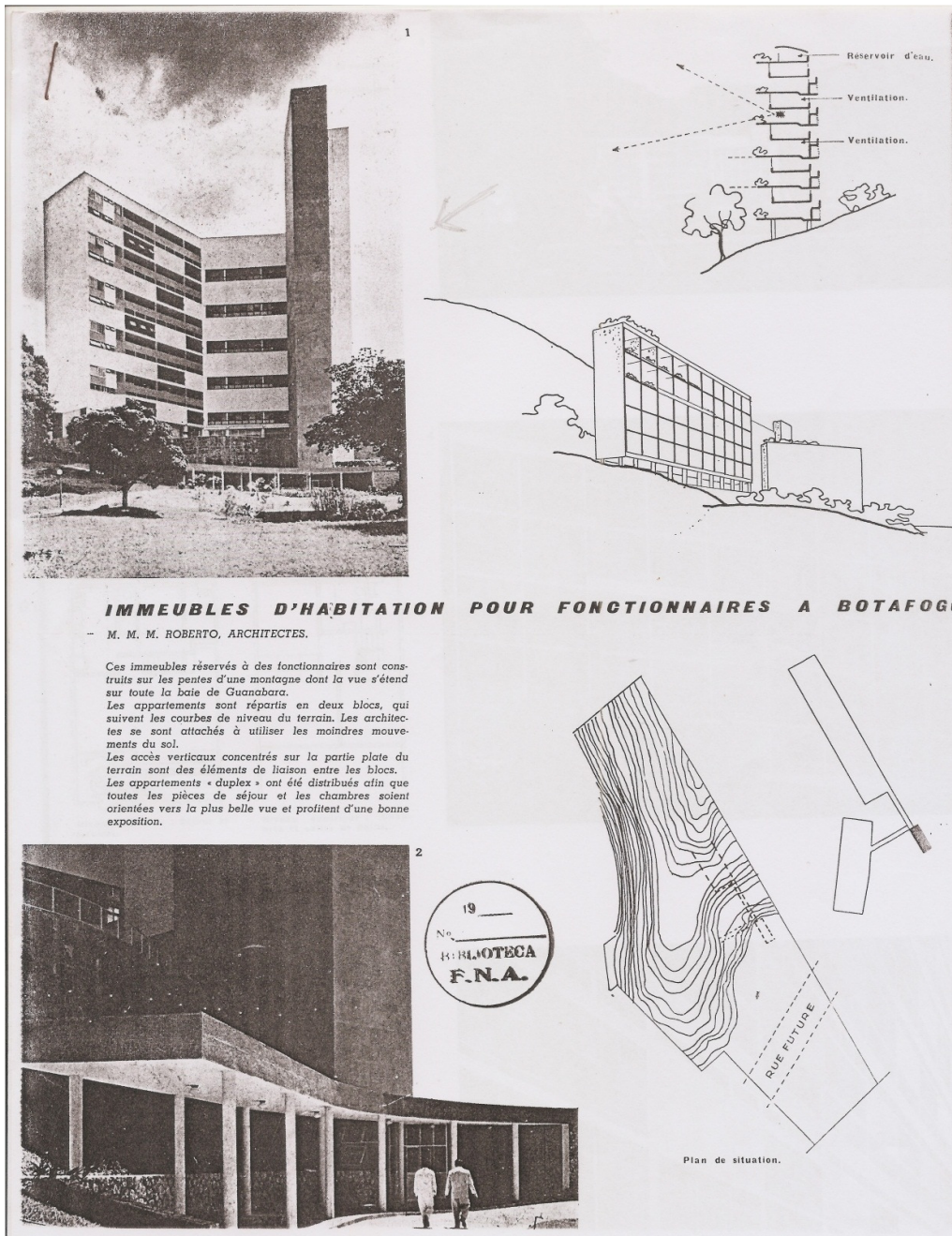
Figura 14E- Matéria da revista l'Architecture d'Aujourd'Hui, de 1947, mostrando a vista do edifício a partir da Rua Farani; um croquis de um corte transversal, explicando a alternância dos corredores; uma perspectiva do bloco B; uma foto da marquise de entrada; e uma planta topográfica do terreno com a implantação dos dois blocos.
