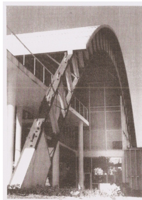
Figura 10G – Foto da estrutura pré-fabricada em madeira
