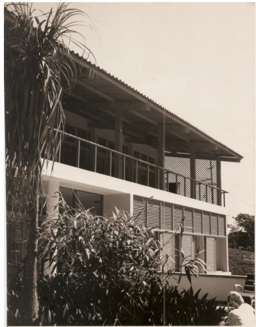
Figura 9B – Foto de trecho fachada frontal
