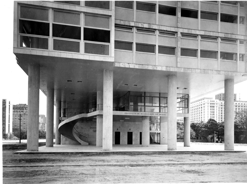
Figura 7C – Foto entrada principal
