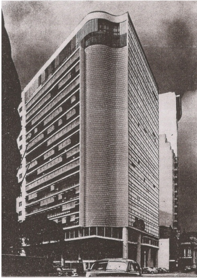
Figura 13C – Foto dos brises-soleils móveis
