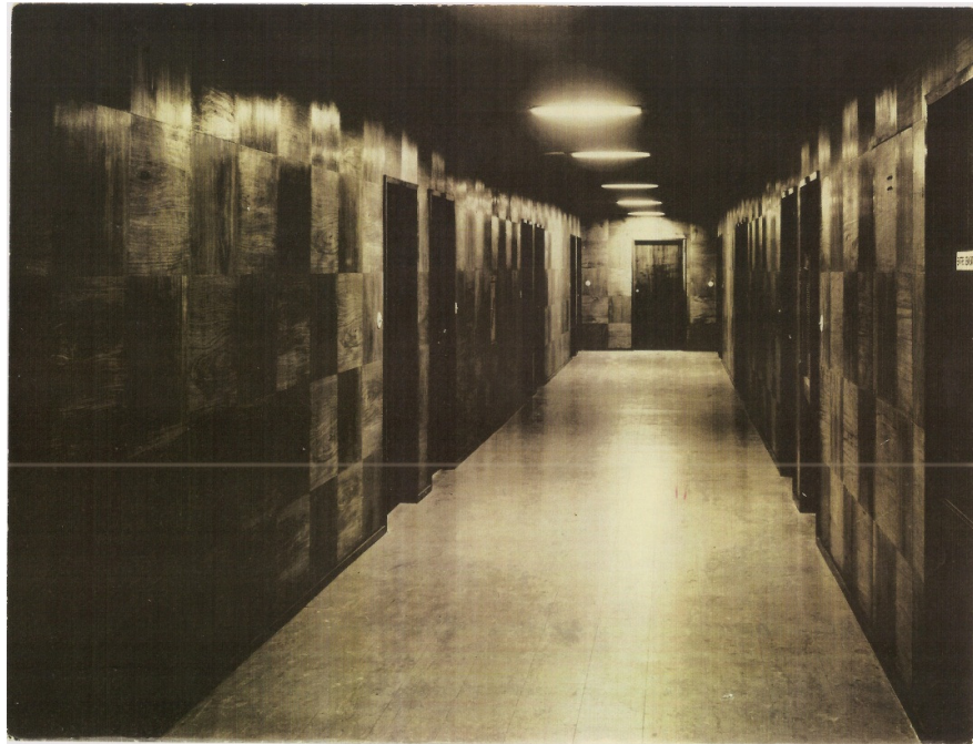
Figura 19F – Corredor pavimento tipo com revestimento em lambris de madeira
