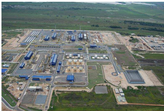
Figura 4.7 – Unidade de Tratamento de Gás de Cacimbas
