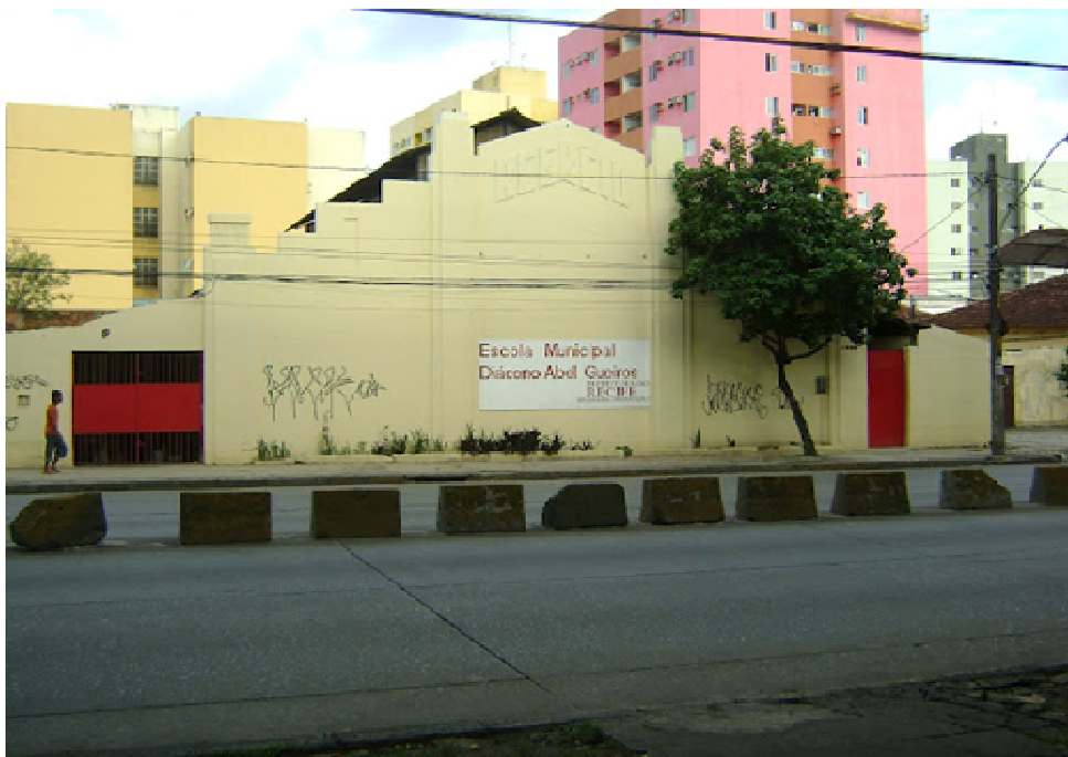
Figura 7 - Prédio construído pelo Cotonifício Bezerra de Mello na década de 1920, em Apipucos, para o recreio dos operários. Disponível em: < http://ocarvel.blogspot.com.br/2012/07/fabrica-da-macaxeira-historia-de-um.html > Acesso em 25 set. 2012
