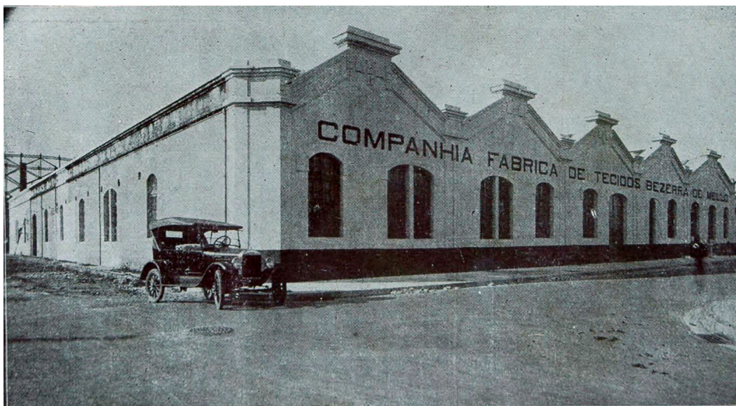
Figura 3 - "Neste vasto e importante edifício da Praça Sergio Loreto funcionará dentro de 3 meses a Companhia Fábrica de Tecidos Bezerra de Mello, uma das mais felizes iniciativas devida ao espírito empreendedor do Sr. Othon L. Bezerra de Mello." Fonte: Revista da Cidade . Ano 1. N. 18. p. 20. 25 set. 1926
