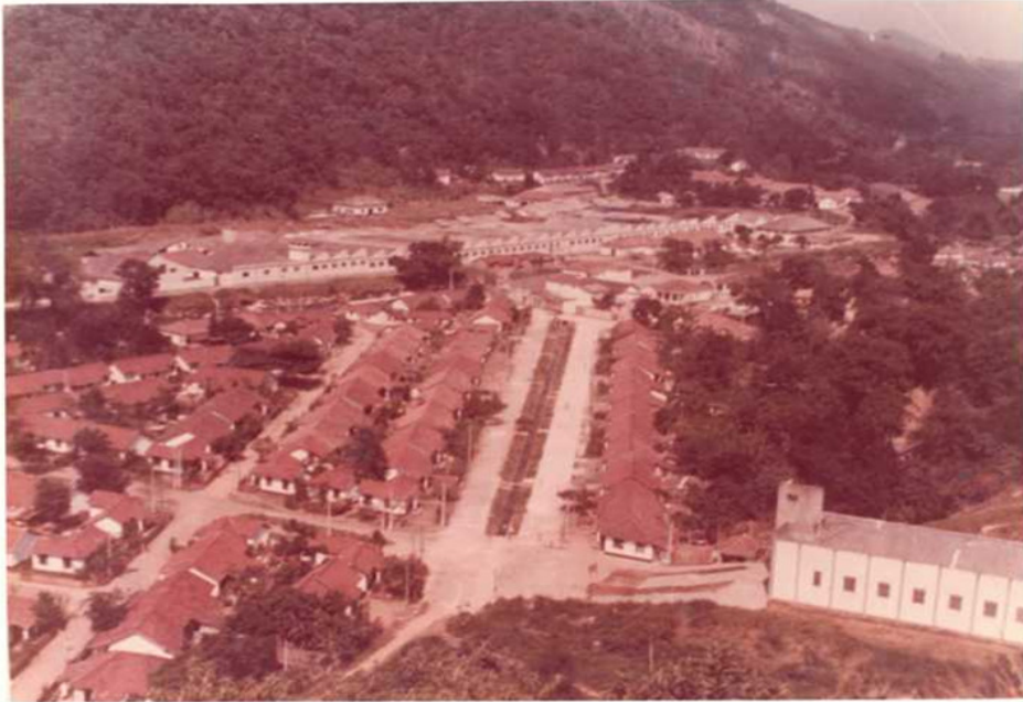
Figura 33 - Vista parcial da nova vila operária. Destaque para a disposição das casas, projetadas de modo que fosse formado um "V", fazendo alusão à vitória do Brasil ao lado dos aliados na Segunda Guerra Mundial. É preciso destacar que o início da construção da vila se deu em 1943. Ao fundo, o prédio de produção da fábrica Esther. 1946. Fonte: autor desconhecido. Acervo de Sonia Gonzaga de Oliveira
