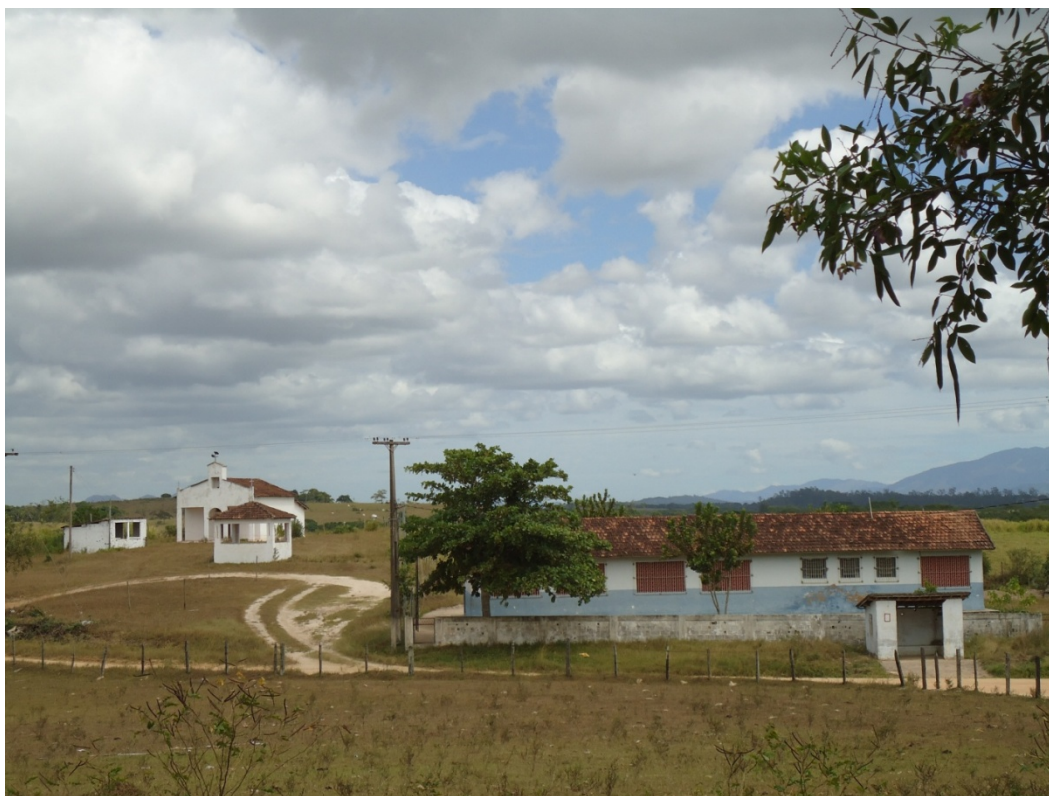
Foto 21: Vista da casa grande, a Igreja e a Escola Municipal. Fonte: Cordeiro, N, 2012.
