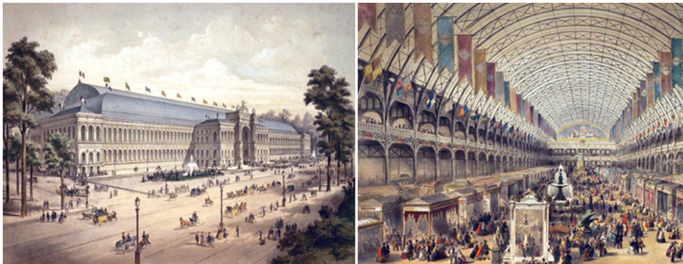
Figura3- Fachada principal e interior do Palais de L'Industrie , com abóbada em estrutura de ferro e cobertura em vidro, cobrindo um vão de 48m de largura, o maior comprimento já feito para uma construção. O maior vão do Crystal Palace tinha 22m de largura.
