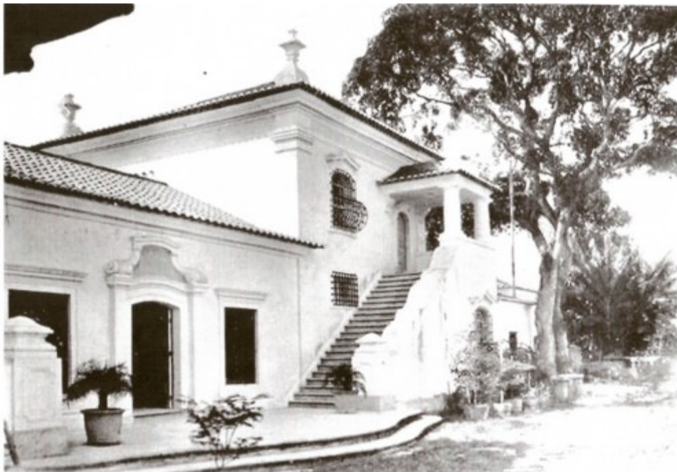
Figura20- Fachada lateral - Solar Monjope (acesso lateral com escadaria e pórtico de acesso).
