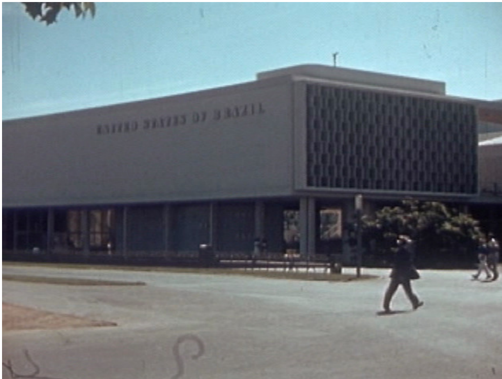
Figura48- Pavilhão do Brasil em 1939. Fachada externa (oeste) em curva, acompanhando a sinuosidade do terreno destinado ao pavilhão, e uma parte da fachada principal (sul) com os elementos vazados
