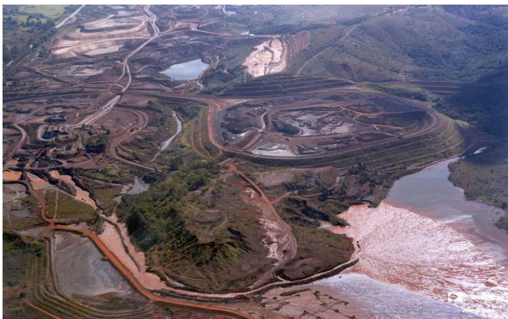
Figura 19 – Terminal Agua Santa próximo a mina Fábricas pertencente á VALE. Fonte: MRS
