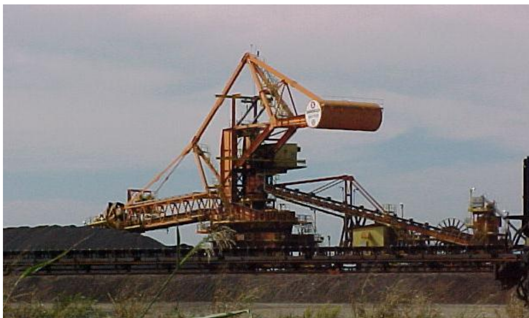
Figura 23 – Stacker e correia de transferência na área de armazenagem. Fonte: MRS
