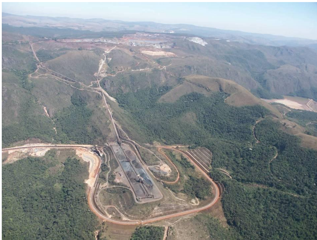
Figura 20 – Terminal Otávio Dapievi - Andaime em formato circular de pês. Fonte: MRS
