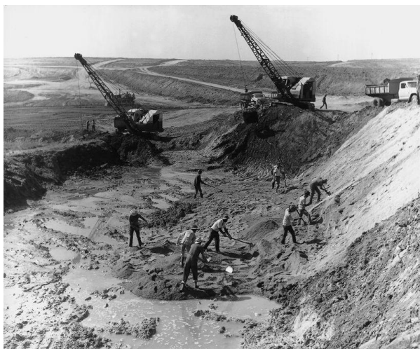
Figura 18 – Início da obras da REVAP Fonte: Petrobras, (2012c).
