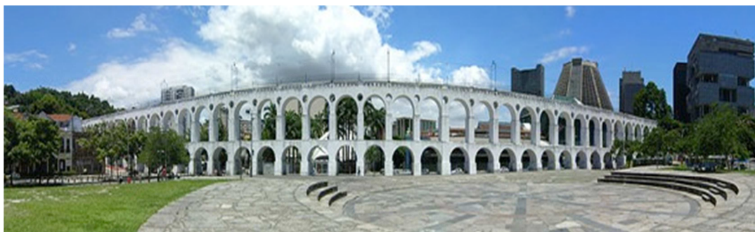
Figura 4 – Panorama do Aqueduto da Carioca Fonte: http://pt.wikipedia.org/wiki/Aqueduto_da_Carioca (2013).
