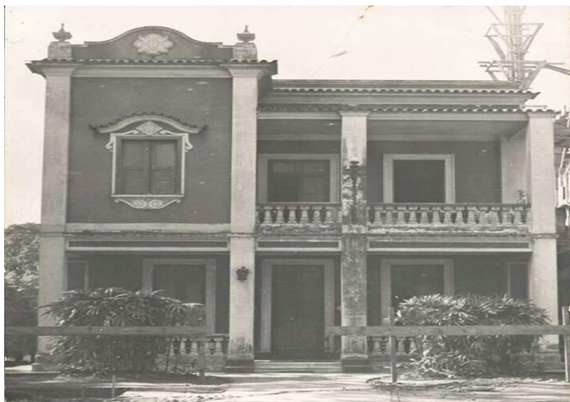
Figura 25: Colégio Nossa Senhora Auxiliadora – Campos/RJ - 1925 Fonte: ACENSA
