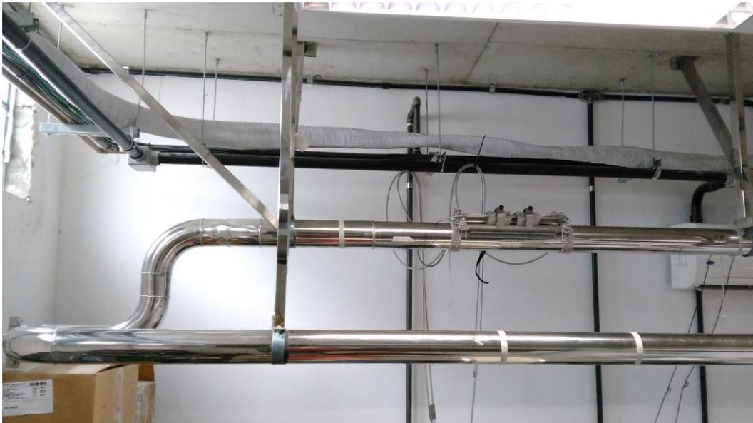
Figura 26: Testes com medidor instalado à montante com 5 DN de trechos retos.
