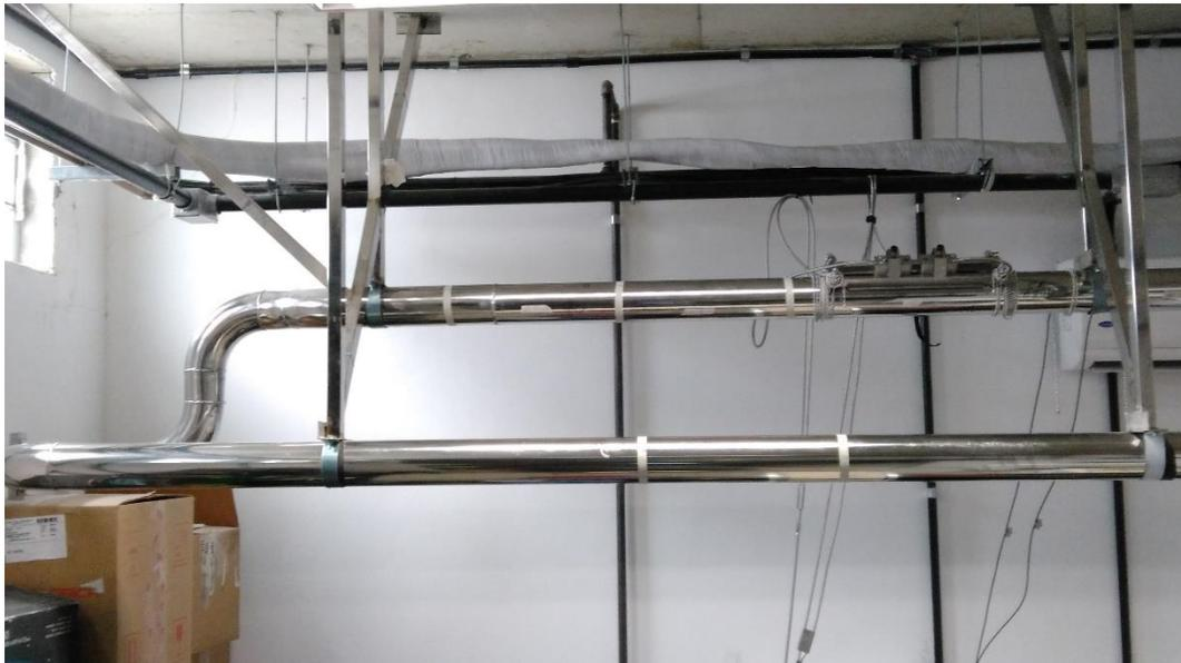
Figura 28: Testes com medidor instalado à montante com 10 DN de trechos retos.
