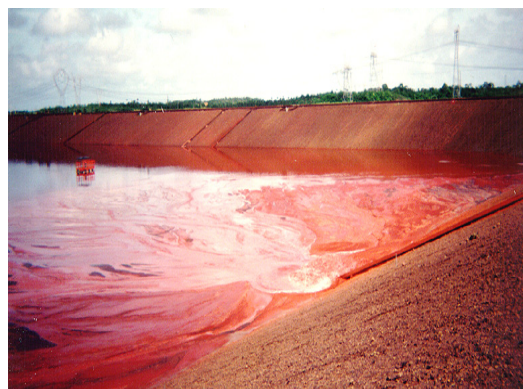
FIGURA 3.39: Lançamento da lama vermelha SL em pontos laterais do reservatório, com formação de praia.
