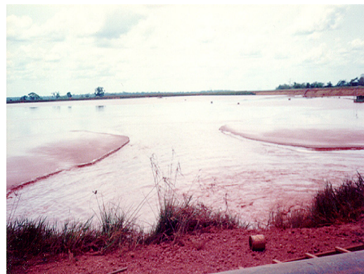
FIGURA 3.37: Lançamento de lama de lavagem de bauxita em dique de contenção. Notar concentração de material mais grosso na lateral.
