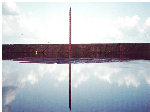
FIGURA 3.38: Torre de lançamento da lama vermelha SL. Notar a formação de praia ao seu redor.
