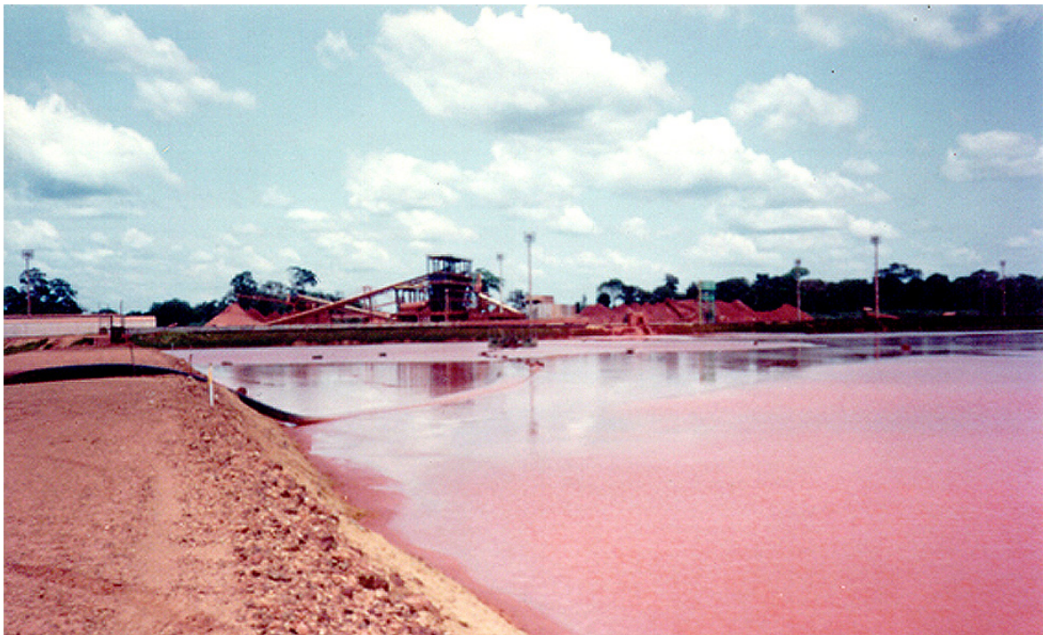
FIGURA 3.4: Vista de um Depósito de Armazenamento de Lamas Vermelhas.
