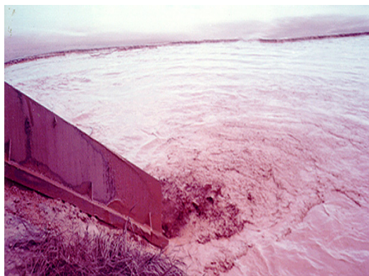
FIGURA 3.36: Detalhe de disposição de lama de lavagem de bauxita. Notar a concentração de grãos mais grossos na parte superior.
