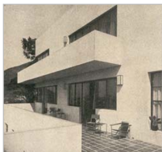
Figura 57. Terraço do terceiro andar
