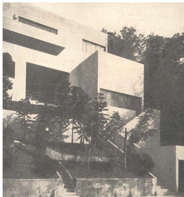
Figura 35. Vista parcial da fachada com escadas da entrada principal
