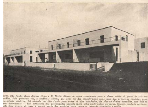
Figura 31. Conjunto residencial da rua Berta. 1930.
