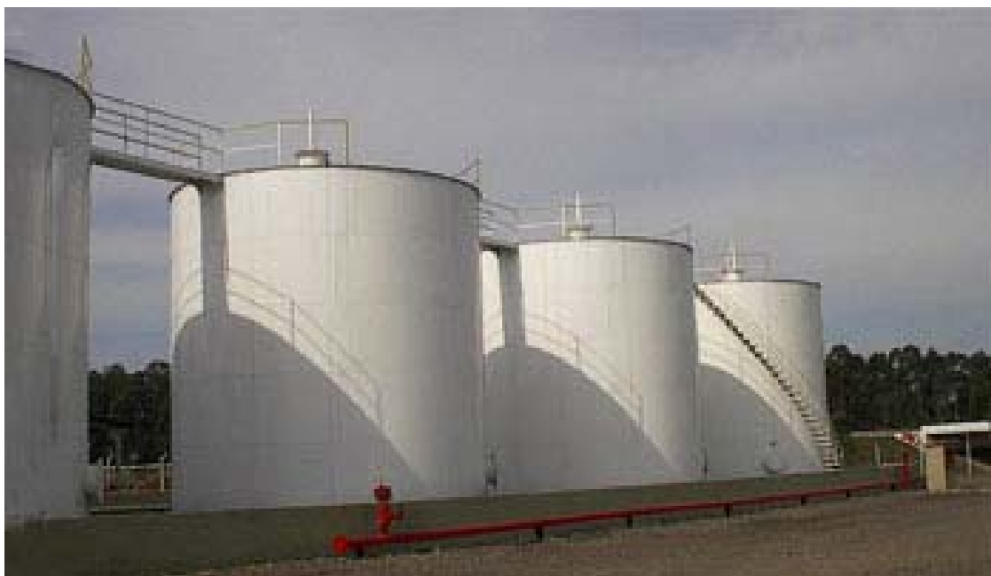
Figura 30 – Tanques Cilíndricos Verticais para Armazenagem de Combustíveis Líquidos.
