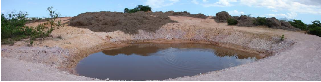
Figura 2-55 Aspecto da Bacia I após o espalhamento da apara de grama no terraço acima, provocando o transporte de ácidos fúlvicos para a bacia trazendo o aspecto escuro para seu espelho d'água (22-11-07).
