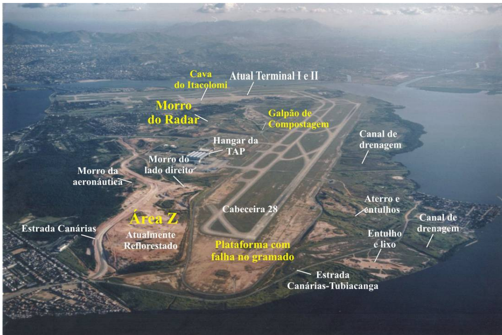
Figura 2-5 Vista geral das principais áreas de intervenção no contexto do Convênio Embrapa/INFRAERO no AIRJ atualmente, sobre foto do final da década de 1970.
