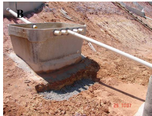
Figura 2-68 A – Selamento da base da caixa 1 da Parcela I evitando infiltrações na estrutura. B – detalhe da fundação com pedra britada formando um piso abaixo da caixa 1 da Parcela II para proteger contra a erosão provocada pela enxurrada que escoar pelos quarteadores.
