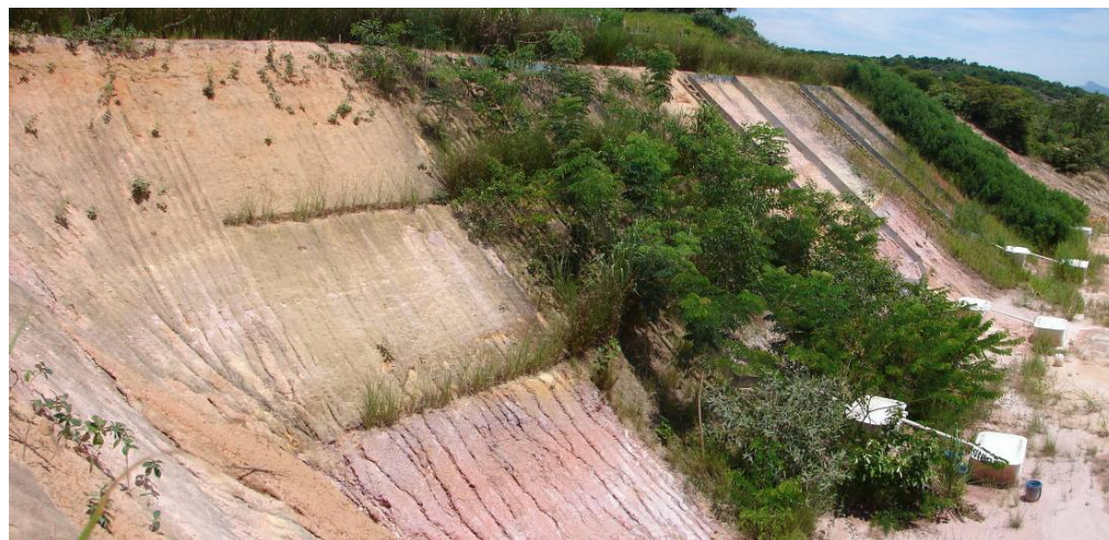
Figura 2-97 Técnicas de Bioengenharia de solos no Talude I.
