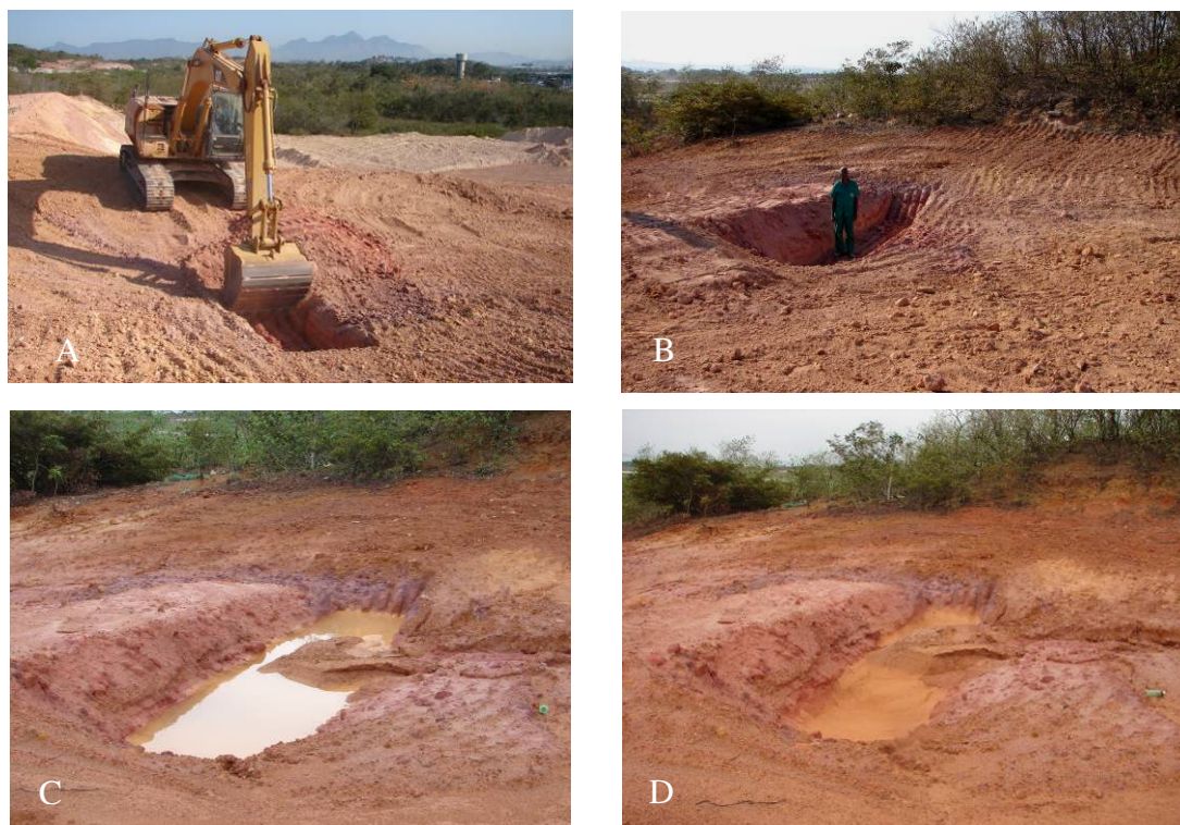
Figura 2-48. (A) construção da Bacia II*. (B) altura de em torno de 0.8 m. (C) água escoando pelo ladrão (C) (13-11-07). (D) sedimentação após as primeiras chuvas (40 mm em 24hs).
