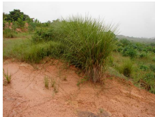
Figura 2-94 Plantio do Capim Vetiver na crista do Talude II.
