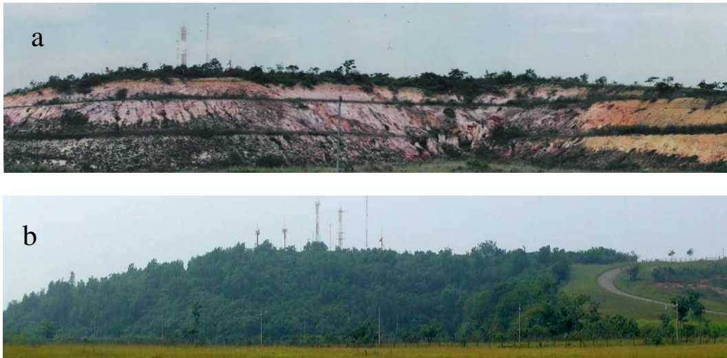
Figura 2-10 Talude de Corte do Morro do Radar antes (a), no ano 2000 (fotode Andrade, A.G.), e após (b) os trabalhos de RAD, no ano de 2004.
