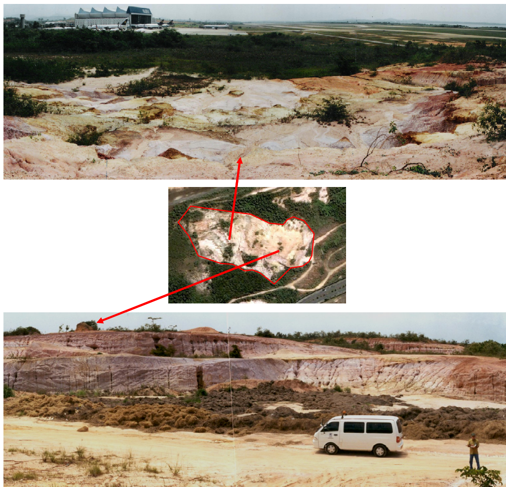
Figura 2-21 Morro ao Lado Direito do Hangar da Varig (atual TAP), fotos do primeiro diagnóstico efetuado pela Embrapa Solos. Acima – vista geral das pistas direita e o Hangar à esquerda, observando-se erosões na vertente onde foi posteriormente conformado o talude; No centro – Imagem do Google Earth realçando a Área Z; Abaixo – reverso da vertente do talude, uma área atualmente utilizada como bota-fora da apara de grama, observa-se o testemunho ao topo do talude.
