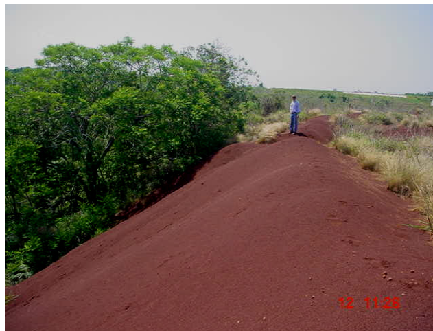
Figura 2-4 Talude no Aeroporto de Foz do Iguaçu na área de empréstimo na cabeceira 14 (Andrade, A.G., Demonte, R.F. Acervo Fotográfico/Convênio Embrapa/INFRAERO).
