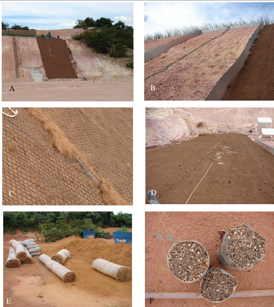
Figura 2-88. A,B – biomanta instalada à direita da Parcela IV. C,D – detalhe da superposição das biomantas. E – biomantas chegando no campo. F – mix de sementes.
