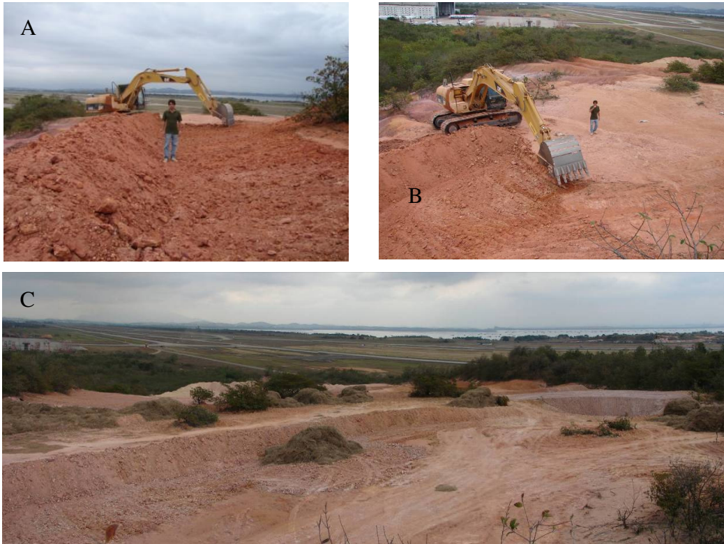
Figura 2-44 Processo de construção do Terraço b. A – Primeiro trecho, próximo ao testemunho. B – curvatura para norte rumo à Bacia I. C – Terraço b logo após sua construção, ainda sem vegetação e cobertura morta.
