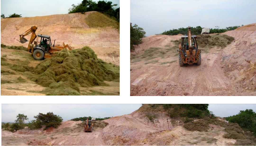
Figura 2-52 Aplicação de apara de grama na área da Voçoroca V.1 com retroescadaveira.
