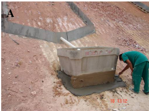
Figura 2-68 A – Selamento da base da caixa 1 da Parcela I evitando infiltrações na estrutura. B – detalhe da fundação com pedra britada formando um piso abaixo da caixa 1 da Parcela II para proteger contra a erosão provocada pela enxurrada que escoar pelos quarteadores.
