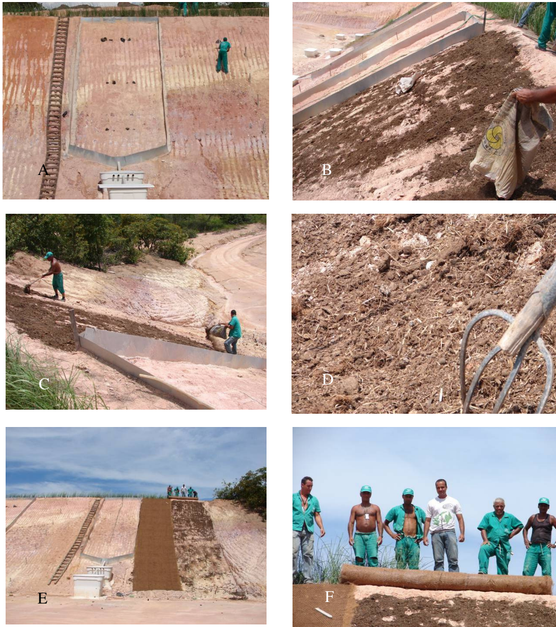
Figura 2-87. A – coveamento do talude. B,C,D - Aplicação e espalhamento de esterço e insumos, E – primeira faixa de biomanta desenrolada no talude. F – pessoal pronto para estender a segunda faixa da manta.
