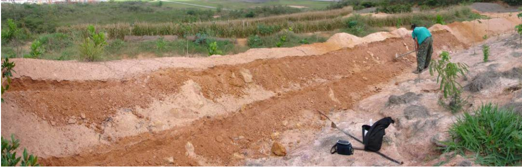
Figura 2-59 Coveamento para plantio do Capim Vetiver em duas linhas de cada lado do Terraço c, utilizando-se a mesma configuração implantada no Morro do Radar.
