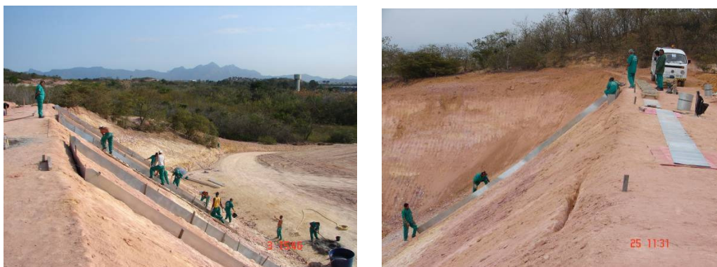
Figura 2-62. Posicionamento das folhas de zinco.
