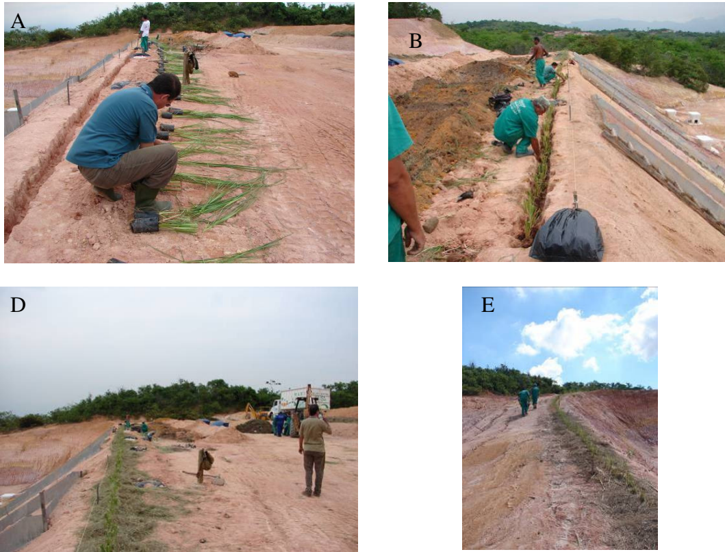
Figura 2-57 Plantio do Capim Vetiver na crista do Talude I. A – poda dos perfilhos. B – plantio em linha com um único sulco. C – coroamento com apara de grama na crista do Talude I. D – talude lateral protegido com Vetiver logo após coroamento.
