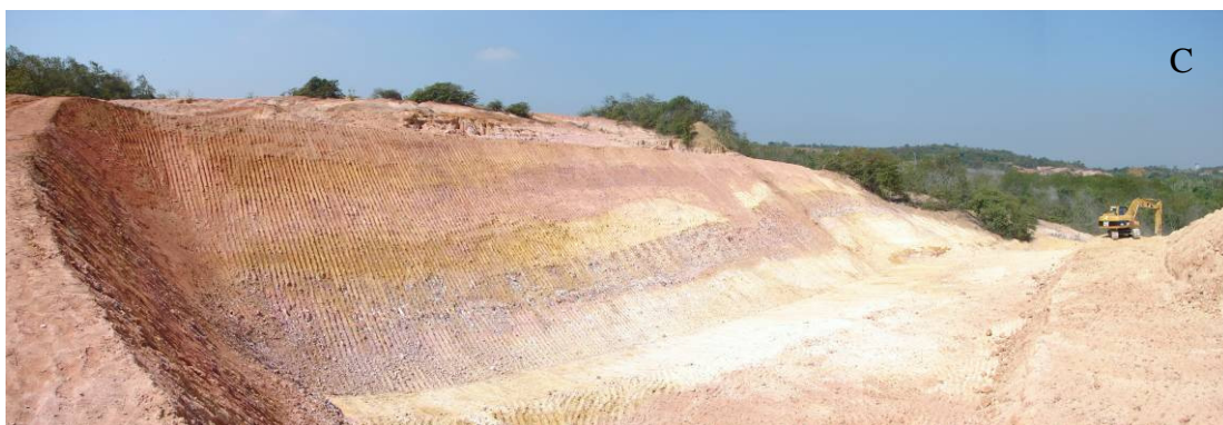
Figura 2-32 Processo de conformação do talude, podendo-se observar o desdobro dos diferentes materiais que compõem material terroso (A,B) e o resultado das diferentes fácies facilmente reconhecíveis ( Ap , ACpb , Amp e Llm ) durante a fase de compactação do aterro (C). Detalhes da discriminação e delimitação espacial destes materiais encontram-se no Capítulo III.
