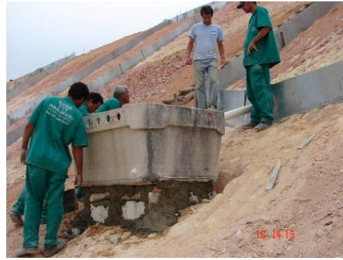
Figura 2-67 Fundação da caixa 1 da Parcela IV, observando-se os rejeitos de concreto reaproveitados de pilhas de entulhos existentes no aeroporto.
