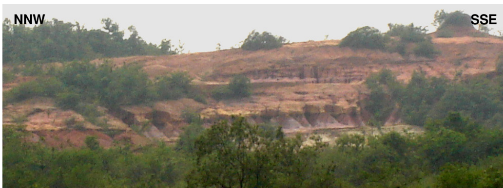
Figura 2-13 Vertente onde foi executado o talude anteriormente às obras, localizada no morro do lado direito do Galpão da TAP.
