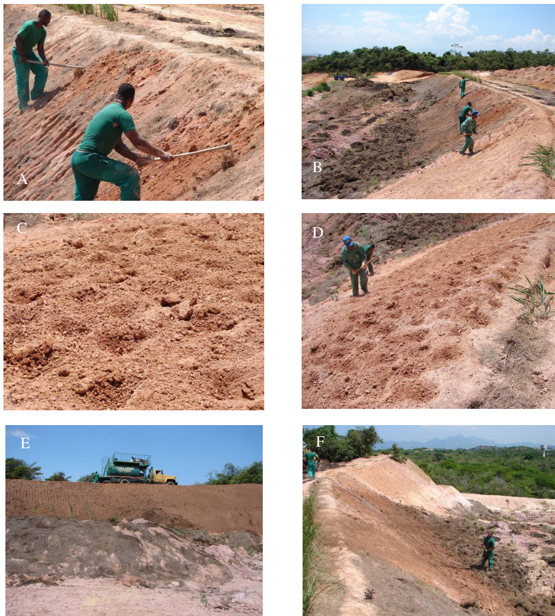
Figura 2-82. A ,B – coveamento do Talude II. C,D – detalhe das covas (micro-covas). E – caminhão de hidrosseadura da empresa Fixa-Verde no acesso acima da crista do Talude II. F – início do jateamento no Talude II.
