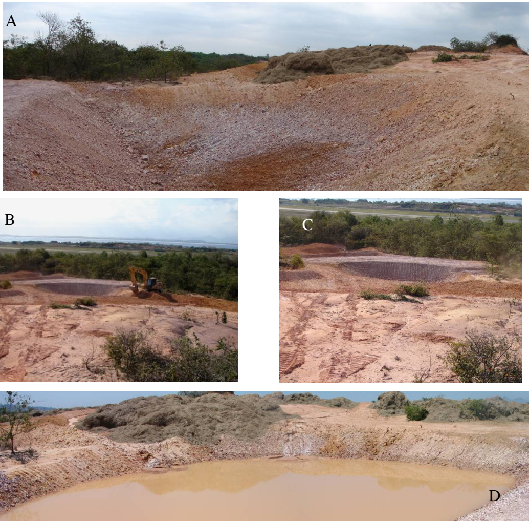
Figura 2-46 A - Bacia I: durante no dia do término da construção, podendo-se observar a profundidade de 1.2 m, bem como sua saia com 3 m de largura (B-C). D – Bacia I após o primeiro período chuvoso (29-10-07).
