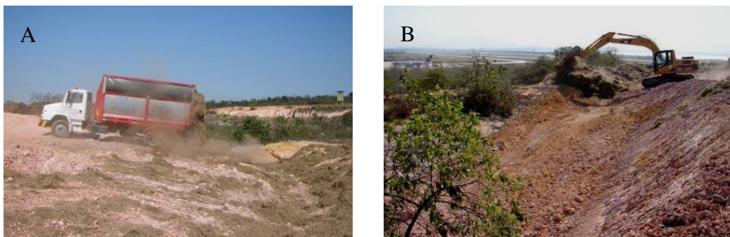
Figura 2-54 Aplicação da apara de grama no Terraço e com auxílio de caminhão (A) e com uma “mãozinha” da escavadeira hidráulica CAT 315C L (B).
