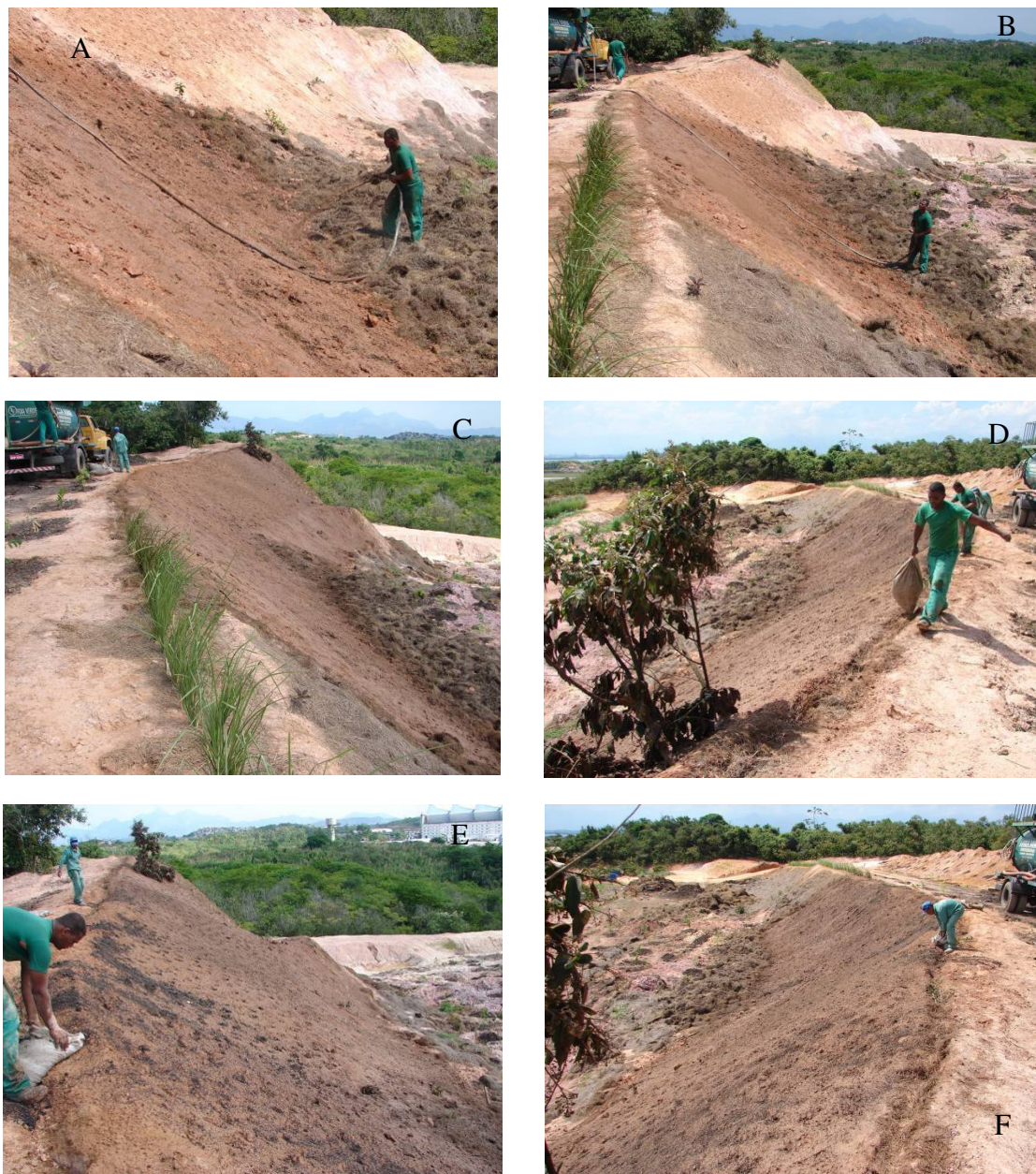
Figura 2-83. A,B – Jateamento no Talude II. C – aspecto do talude após o jateamento. D,E,F - aplicação de esterco e megamulch .
