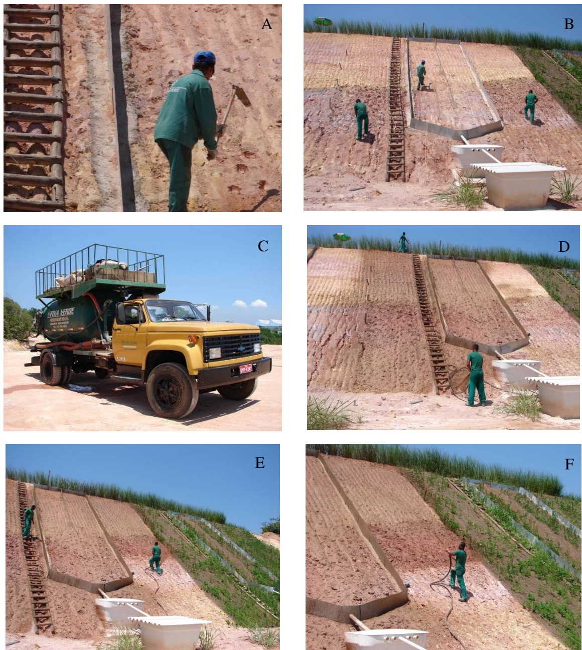
Figura 2-80 A,B – coveamento da área da parcela. C – caminhão pipa adaptado para hidrosseadura da empresa Fixa Verde. D, E,F – jateamento da hidrosseadura.
