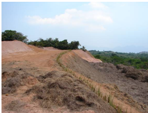
Figura 2-94 Plantio do Capim Vetiver na crista do Talude II.
