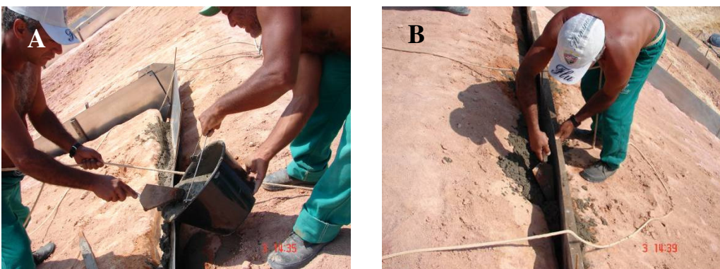
Figura 2-63 - A - Chumbamento das folhas com concreto. B – uso de gabarito para posicionar as folhas na crista adequadamente.
