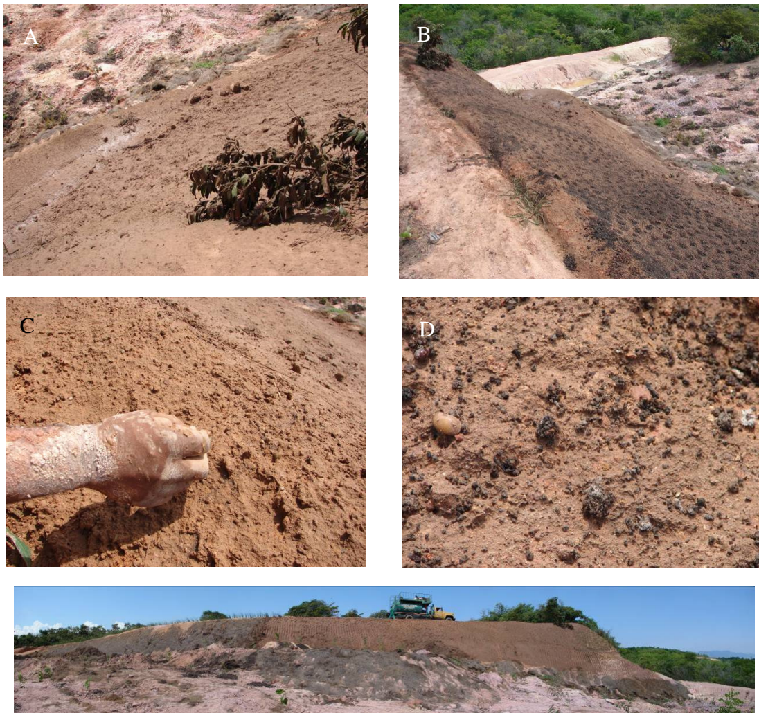
Figura 2-84 Aspecto da superfície do solo antes (A) e após (B) o recobrimento final com esterco e megamulch. C, detalhe do aspecto da massa, observando-se sua aderência nas mãos do funcionário. D – semente de feijão-guandu. E – aspecto final do Talude II após a aplicação da hidrossemeadura.
