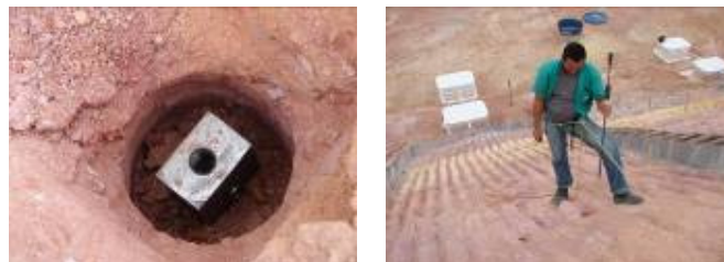
Figura 4-63 Processo de inserção no talude com o gabarito.
