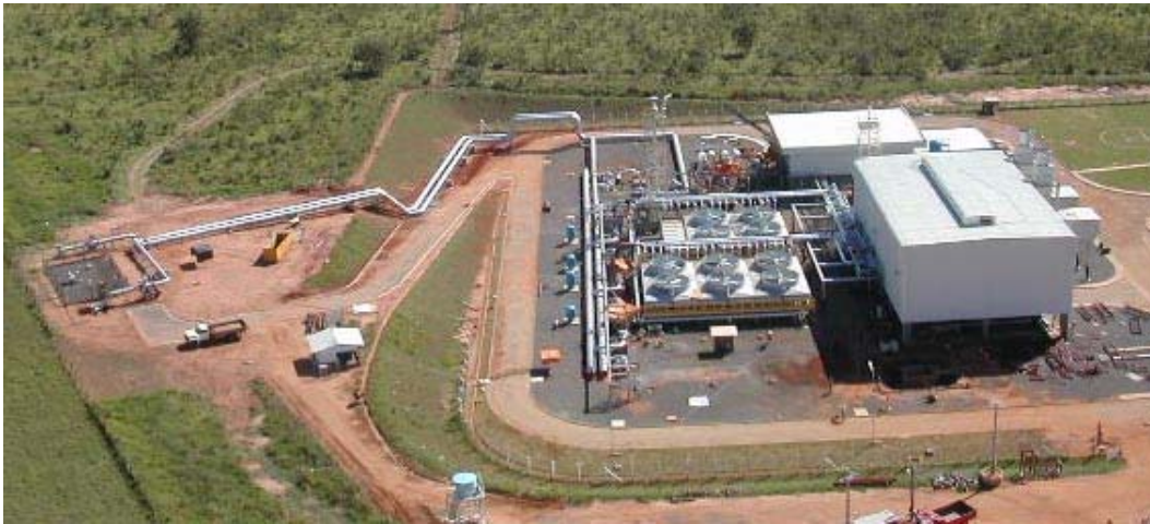
Figura 9 - Estação de Compressão Típica do Gasbol
