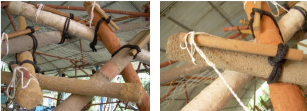
Figura 63 – O giro em detalhe e a amarração com corda e torniquete de madeira
