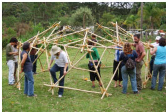
Figura 67 – Módulos empilhados e armazenados e montagem do domo por módulos
