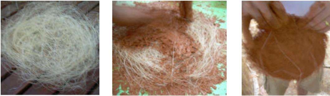
Figura 53 – Montando placas de fibro-barro.
