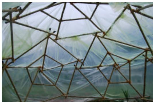
Figura 68 – Finalizando a montagem e revestindo com plástico a estufa
