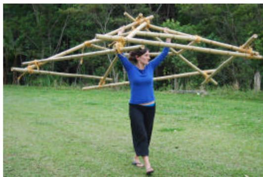
Figura 66 – Montando módulos pentagonais em um gabarito e transportando o módulo
