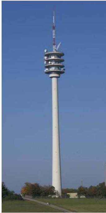
(a) Aufhausen Transmission Tower ;
