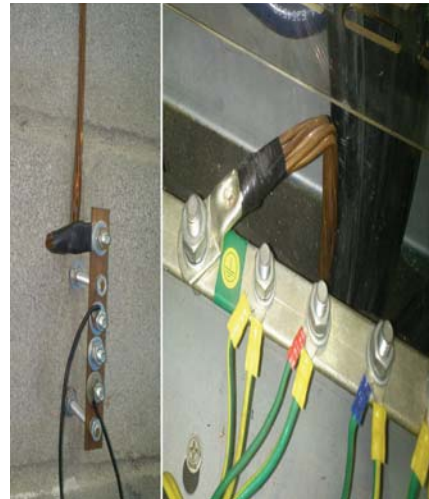
Figura 3.29: Terra de medição e de alta potência utilizados no projeto.
