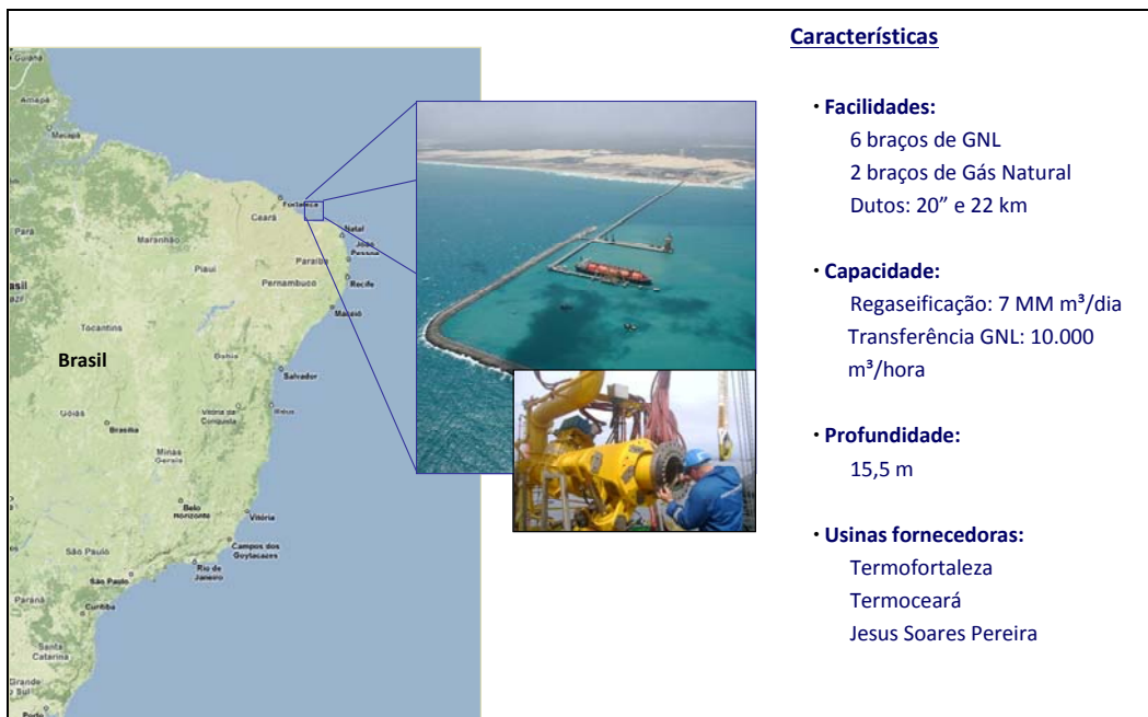
Figura 40 - Terminal Flexível de GNL de Pecém no Ceará. Fonte: Barros (2012).
