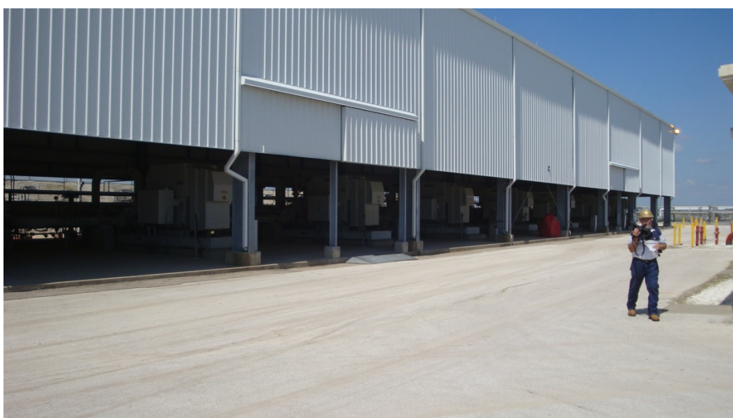
Figura B3 - Bombas para despacho do óleo (1,5 milhões BPD), Fonte: COSTA et al., 2009.
