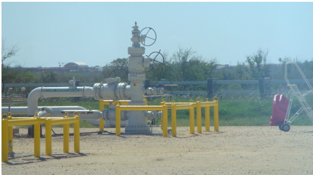
Figura B1 - Árvore de Natal de operação de uma das cavernas, Fonte: COSTA et al., 2009.
