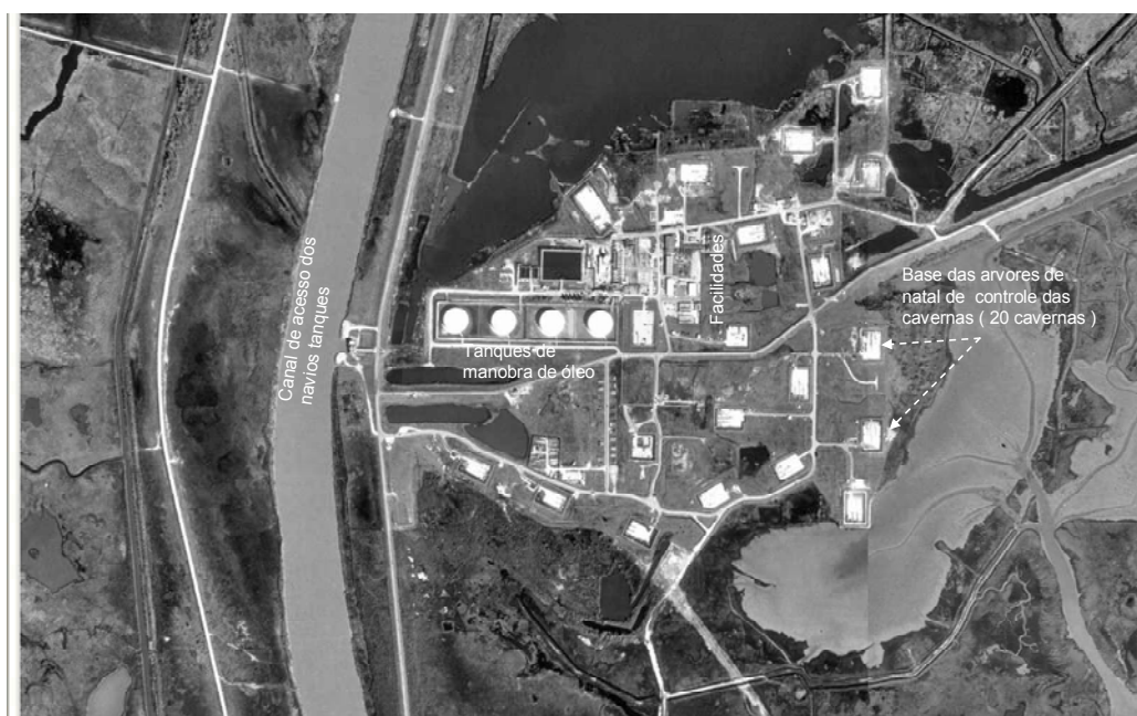
Figura B4 - Visão de satélite da base de estocagem de óleo do SPR - Bryan Mound, Fonte: COSTA et al., 2009.
